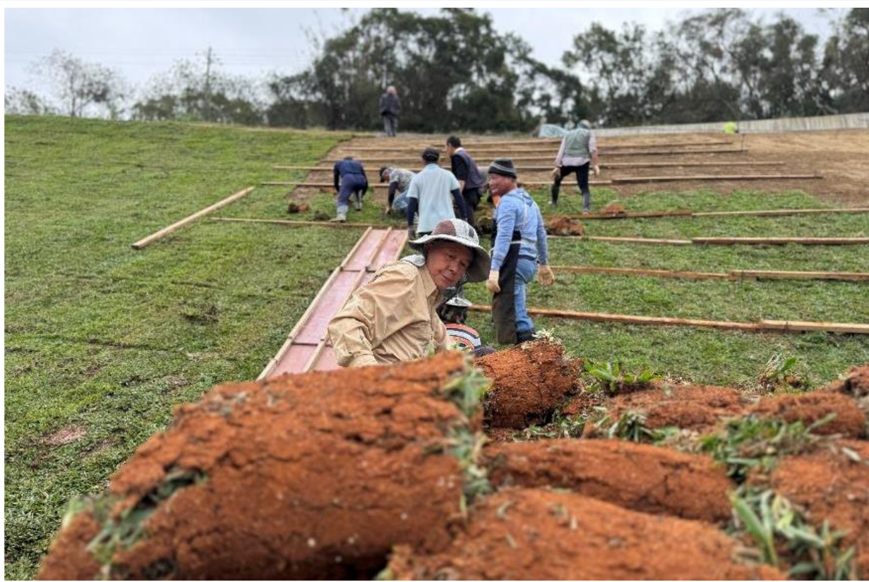
義工施作草皮排水溝 2024/12月
