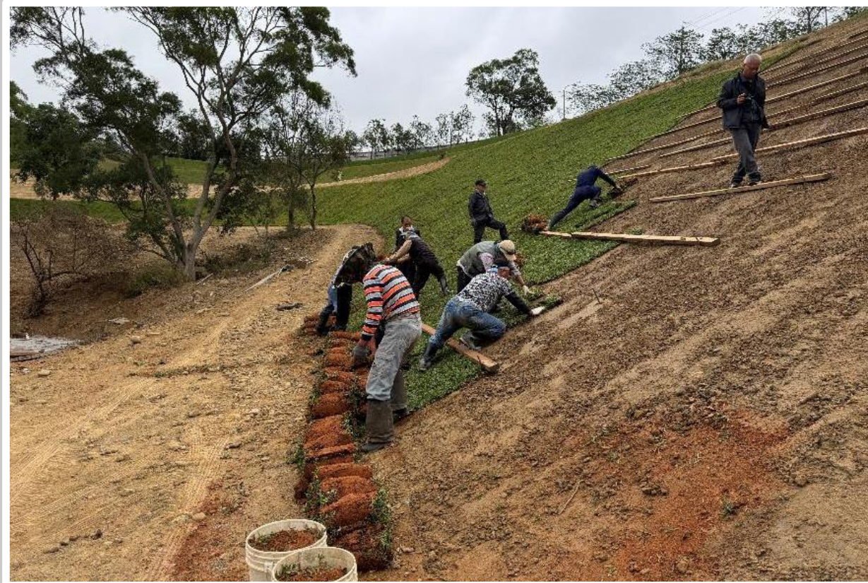
義工施作草皮排水溝 2024/12月
