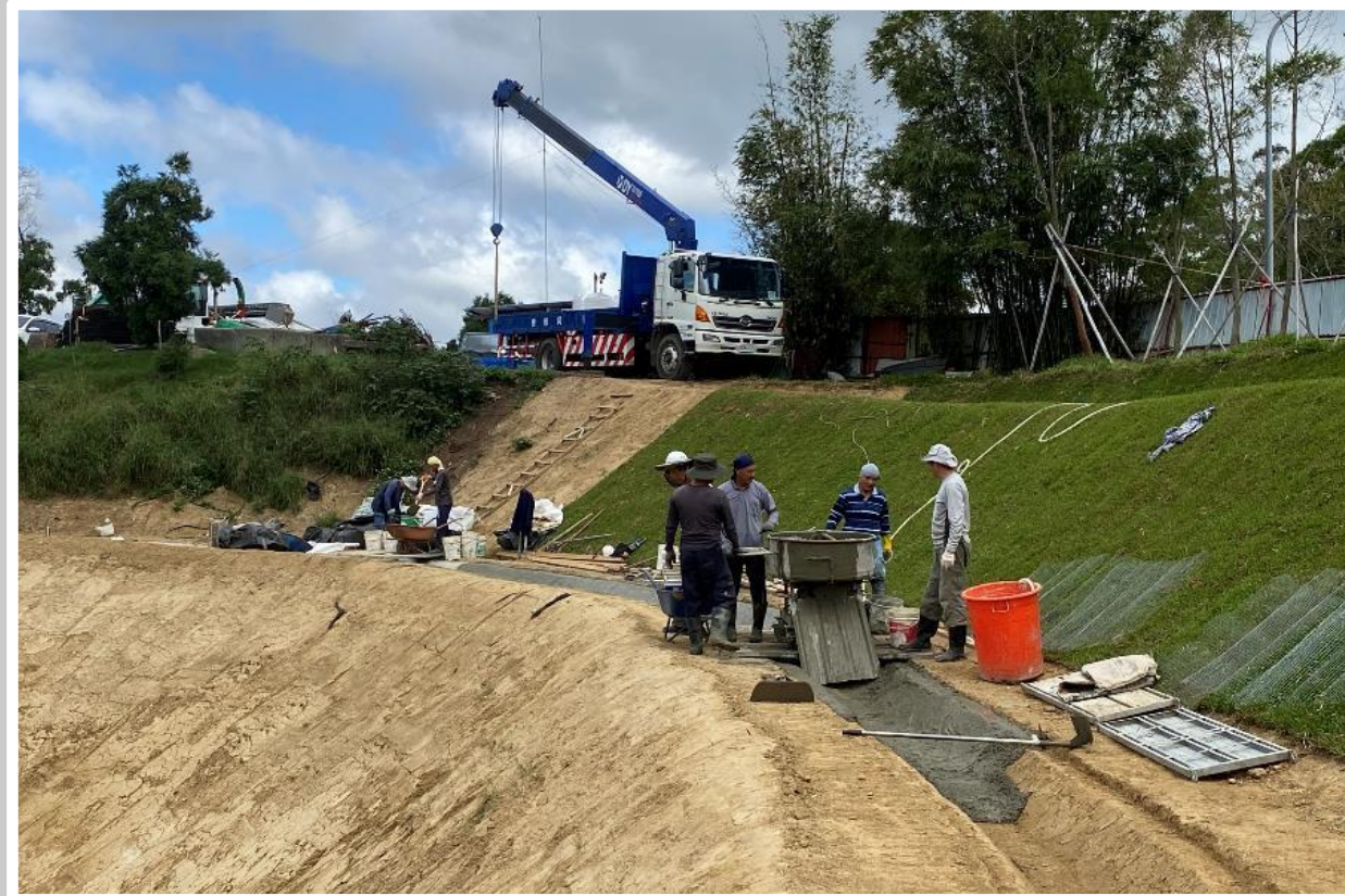
義工施作回填區排水溝 2024/12月
