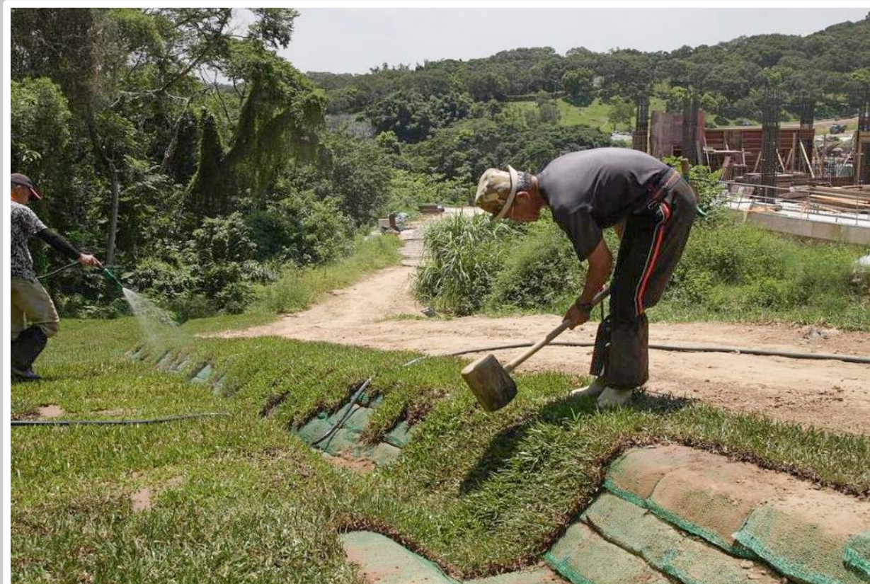
義工施作草皮排水溝 2024/6月
