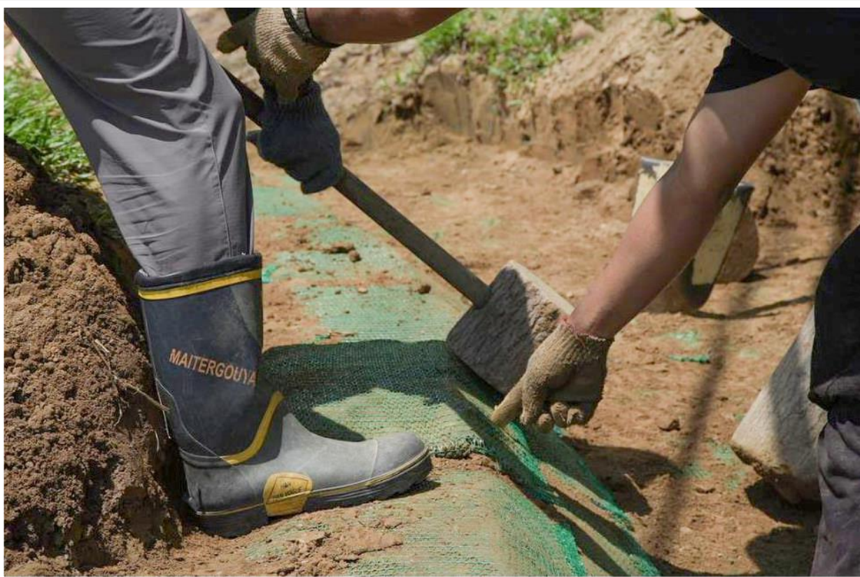
義工施作草皮排水溝 2024/6月
