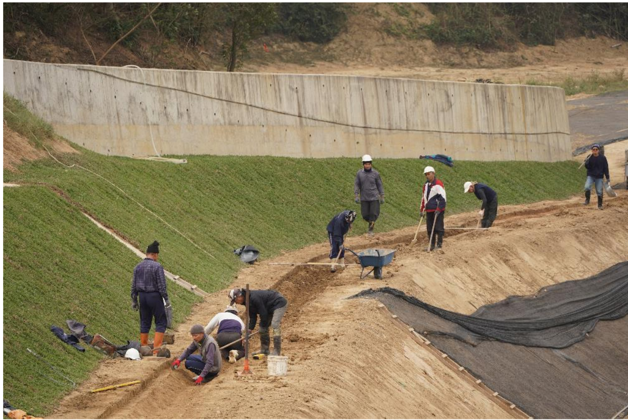
義工施作回填區排水溝 2024/12月
