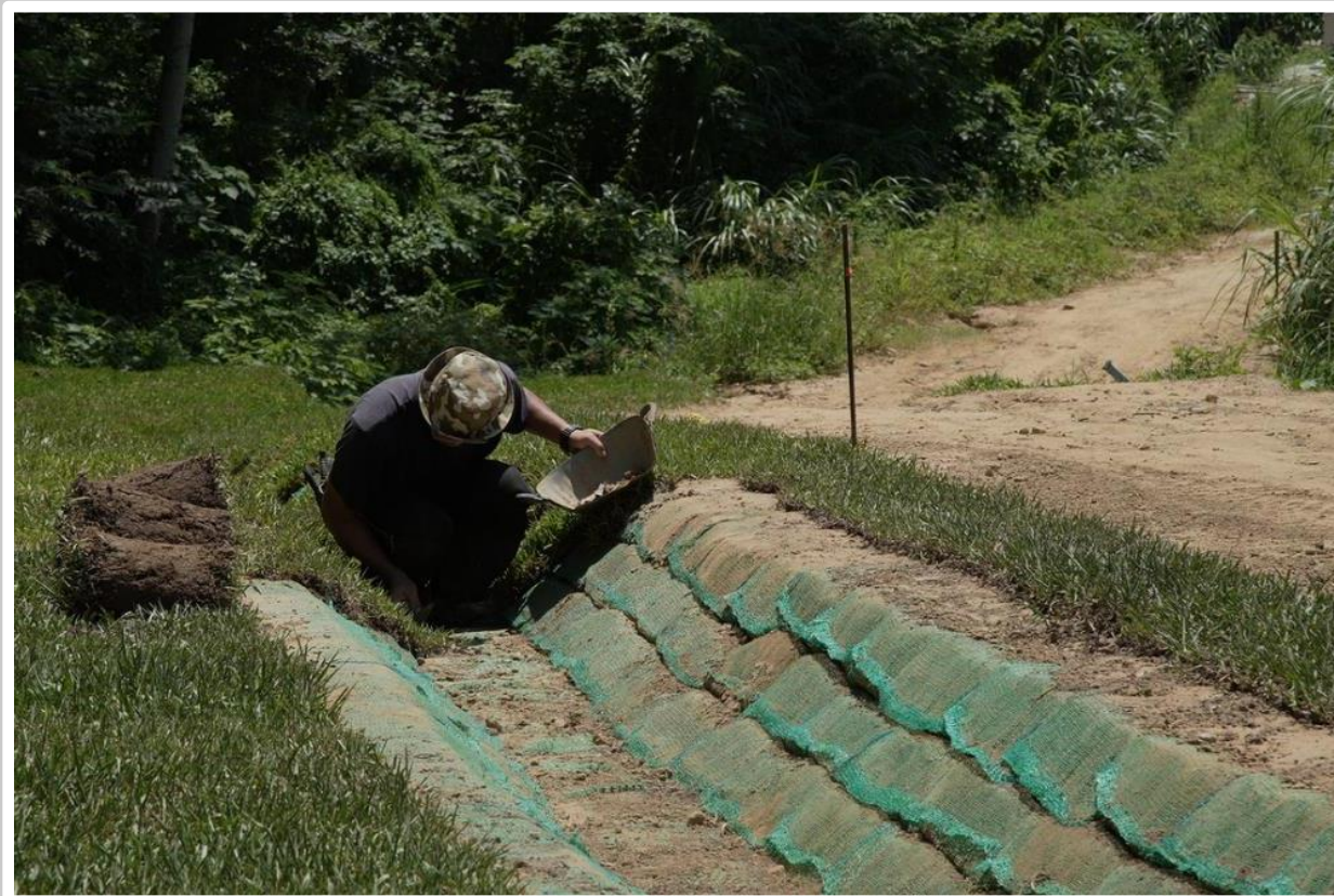
義工施作草皮排水溝 2024/6月
