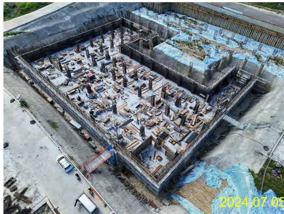
主殿B2F鋼筋模板、機電施作
