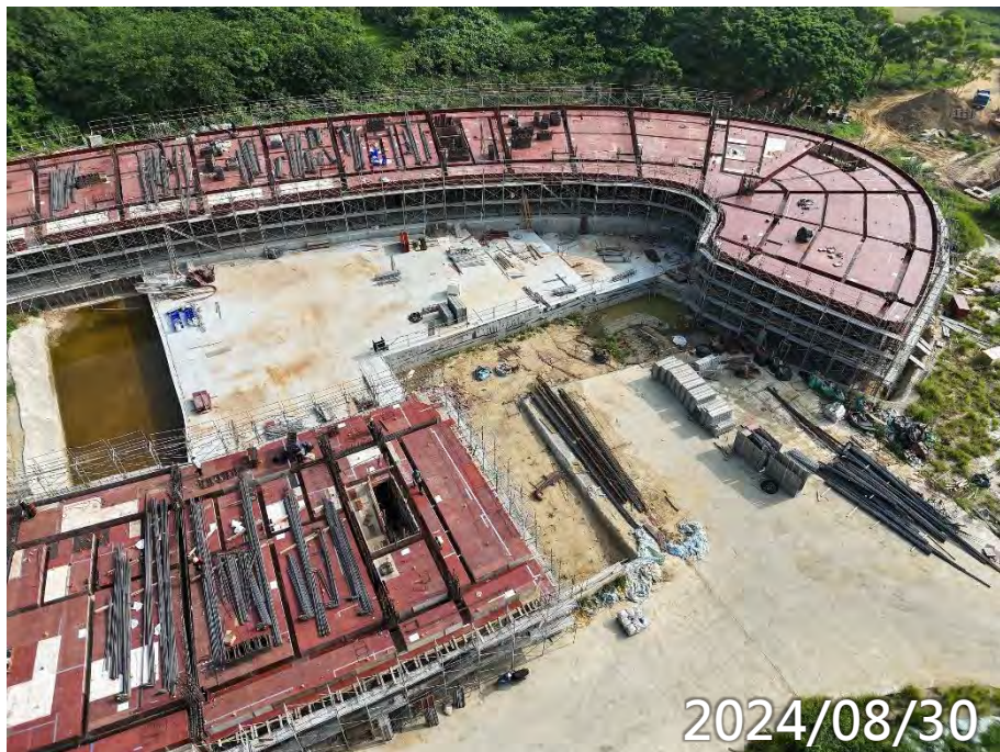
女寮1、3區2F梁版鋼筋模板水電施作
