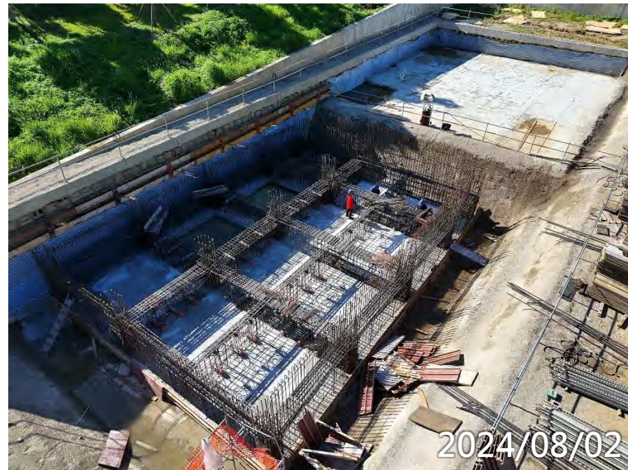
男義工基礎層鋼筋綁紮
