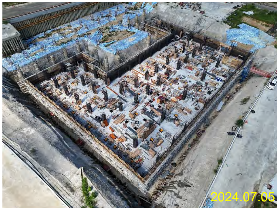
主殿B2F鋼筋模板、機電施作
