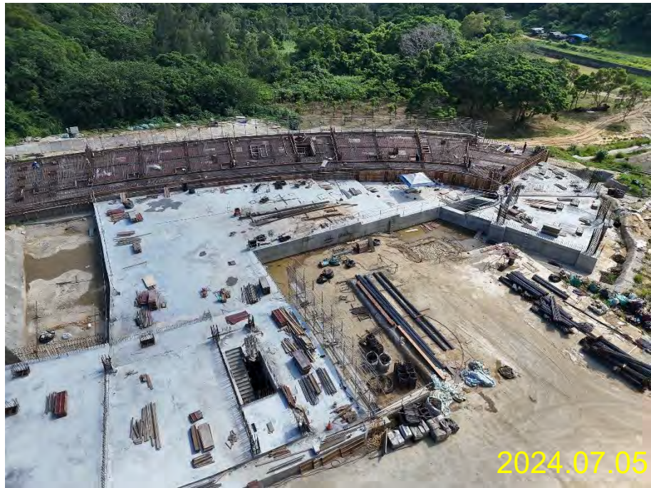
女寮1區1F柱牆鋼筋、模板、水電施作
