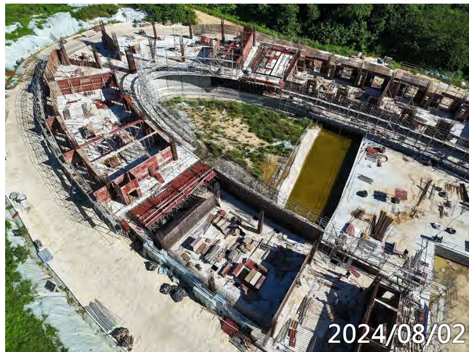
女寮2區2F柱牆鋼筋模板水電施作
