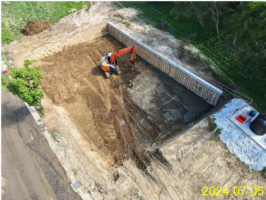
男常住機電接地、土方細整、噴漿護坡
