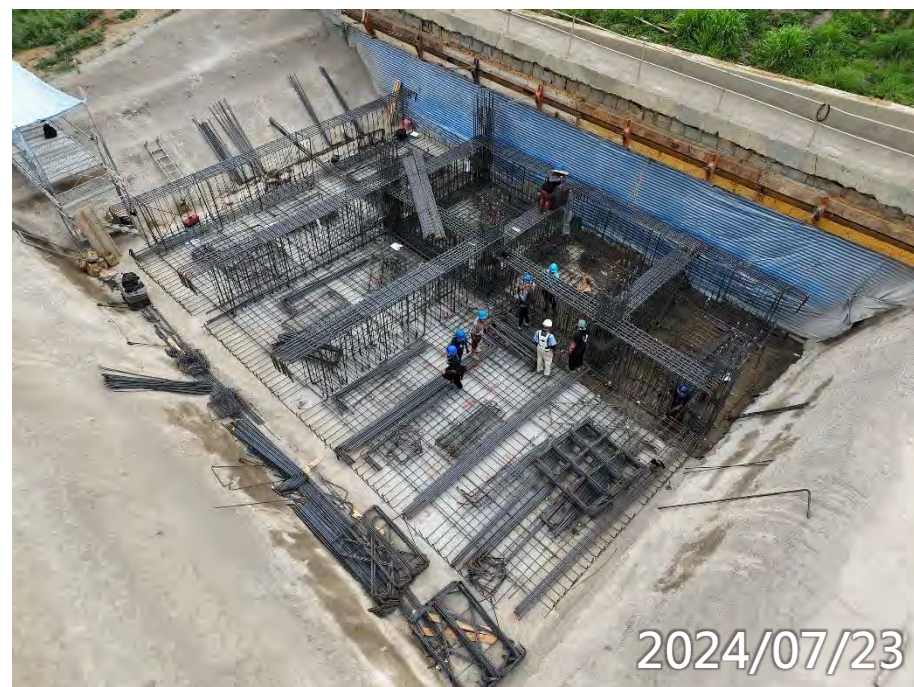
男義工基礎層鋼筋綁紮
