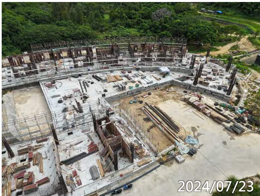
女寮1、3區1F柱牆鋼筋模板水電施作 防颱作業
