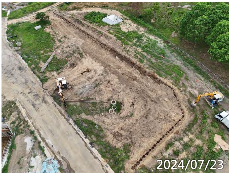
男寮鋼軌樁打設
