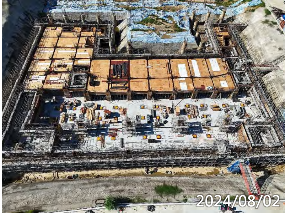
主殿1區B2F柱牆、B1F梁版 鋼筋模板水電施作
