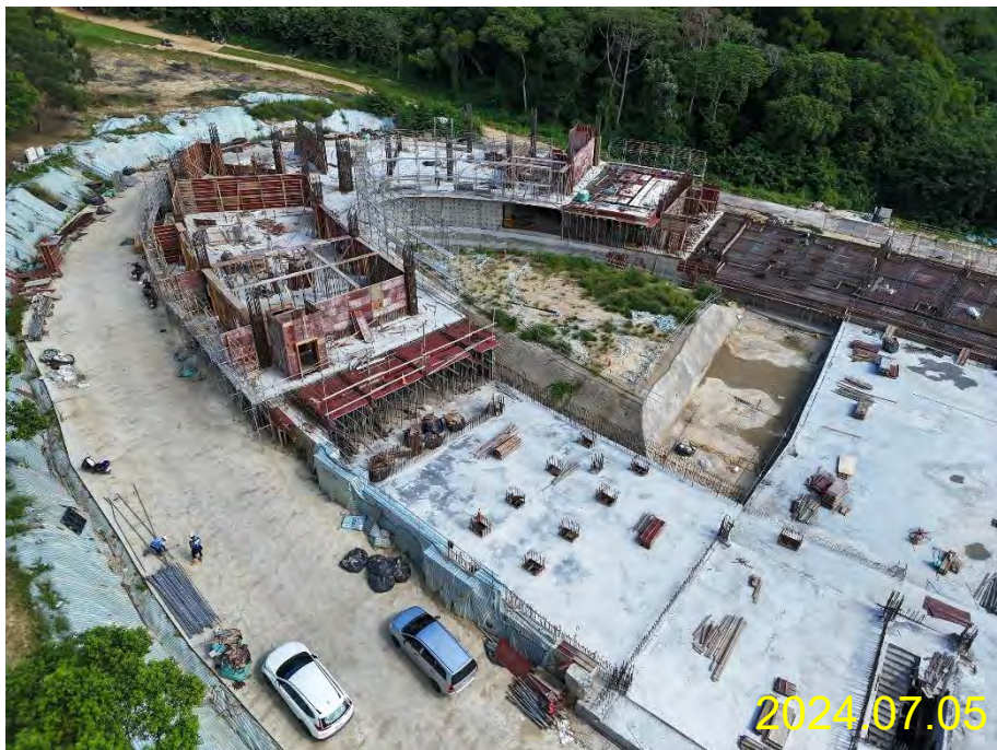
女寮2區2F柱牆鋼筋、模板、水電施作 2-2區1F施作
