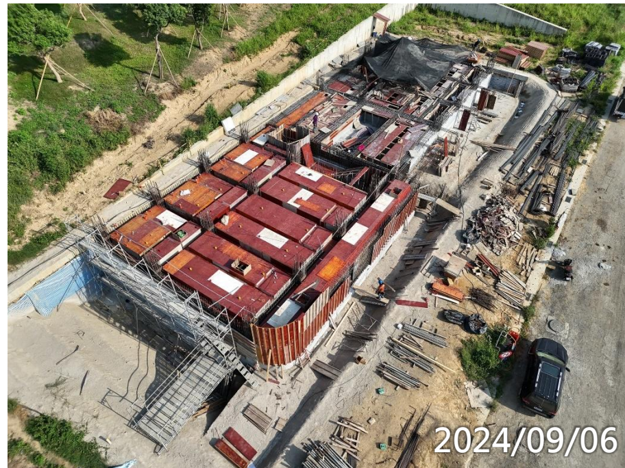
男義工低版區B1F、高版區地梁 鋼筋模板水電施作
