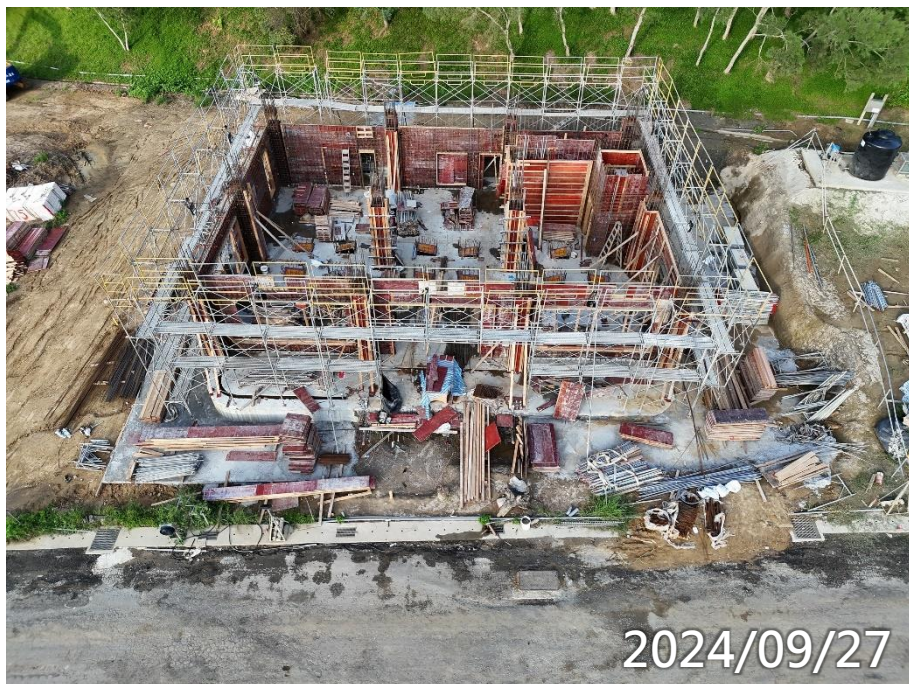
男常住1F柱牆鋼筋模板水電施作
