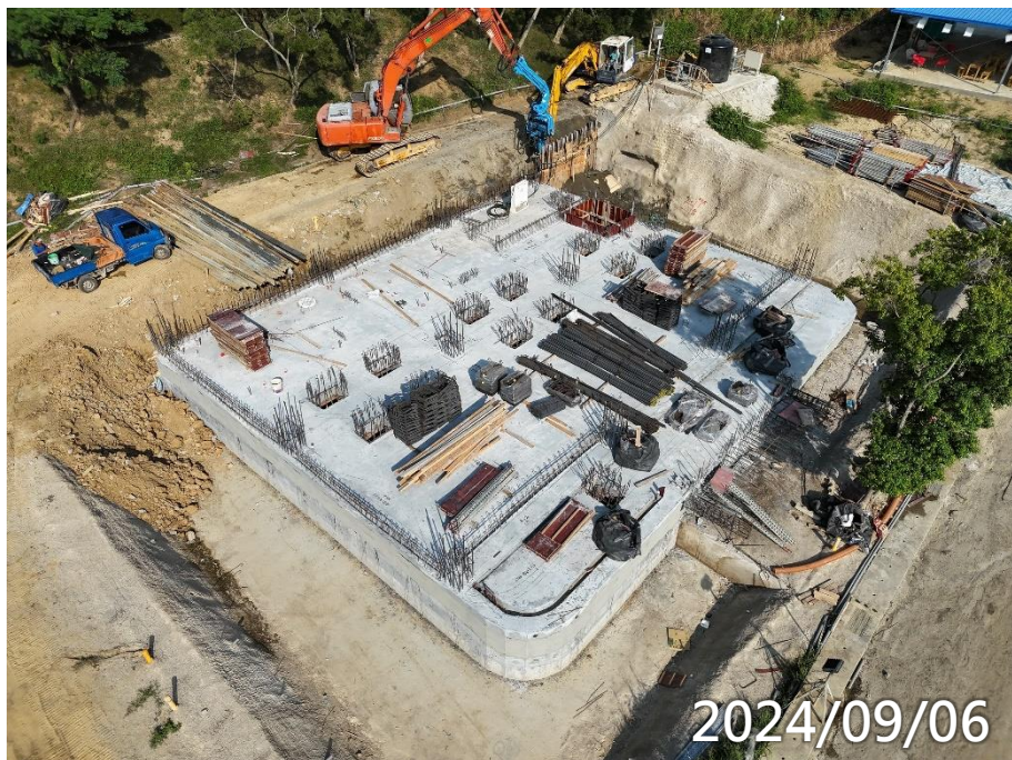
男常住鋼軌樁拆除、土方回填
