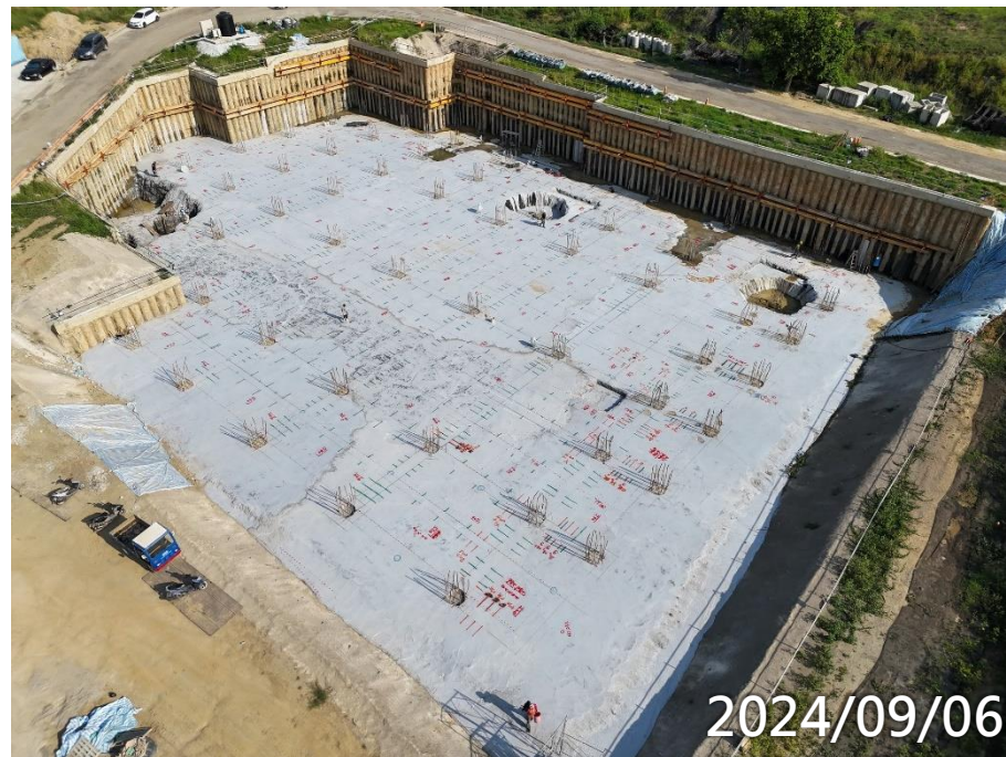
齋堂基礎層鋼筋水電放樣
