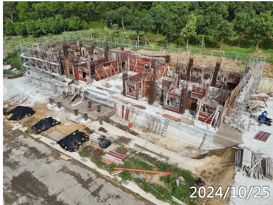
男義工1F柱牆鋼筋模板水電施作
