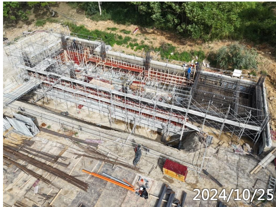
司機休息室B1F柱牆鋼筋模板水電施作
