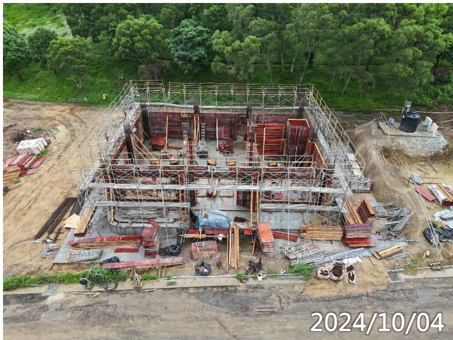
男常住1F柱牆鋼筋模板水電施作
