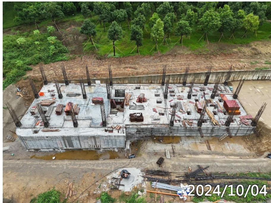
男義工B1F柱牆拆模
