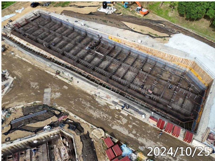
男寮基礎層鋼筋模板水電施作
