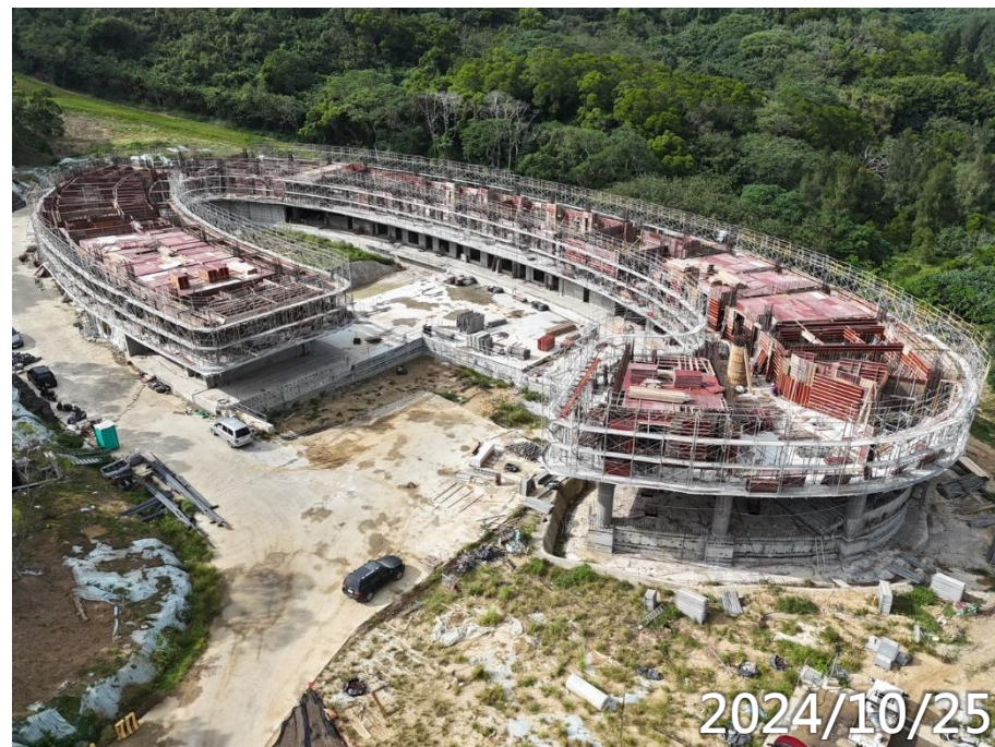
女寮2F柱牆鋼筋模板水電施作
