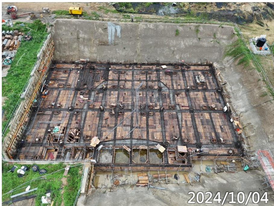
玄文BS版鋼筋模板水電施作
