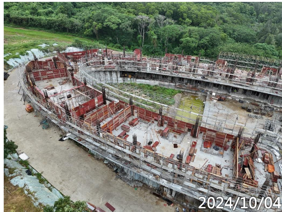
女寮2F柱牆鋼筋模板水電施作
