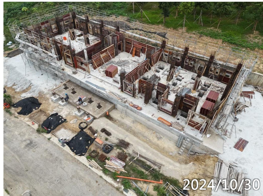
男義工1F柱牆鋼筋模板水電施作
