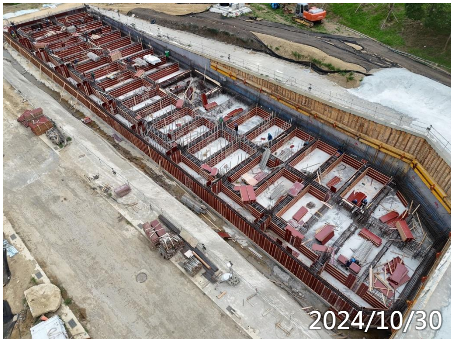
男寮基礎層鋼筋模板水電施作
