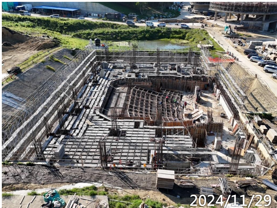
玄文B1F柱牆鋼筋模板水電施作
