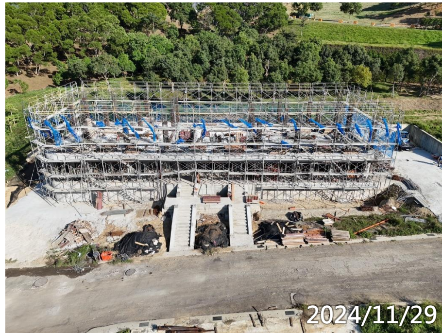
男義工2F柱牆鋼筋模板水電施作
