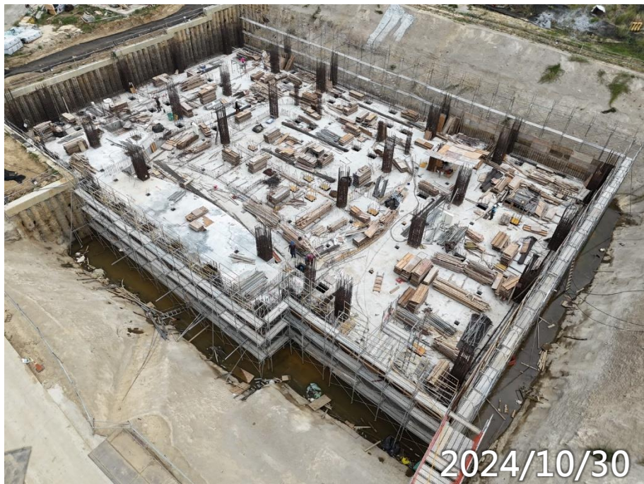
玄文B1F柱牆鋼筋模板水電施作 筏基劣質回填
