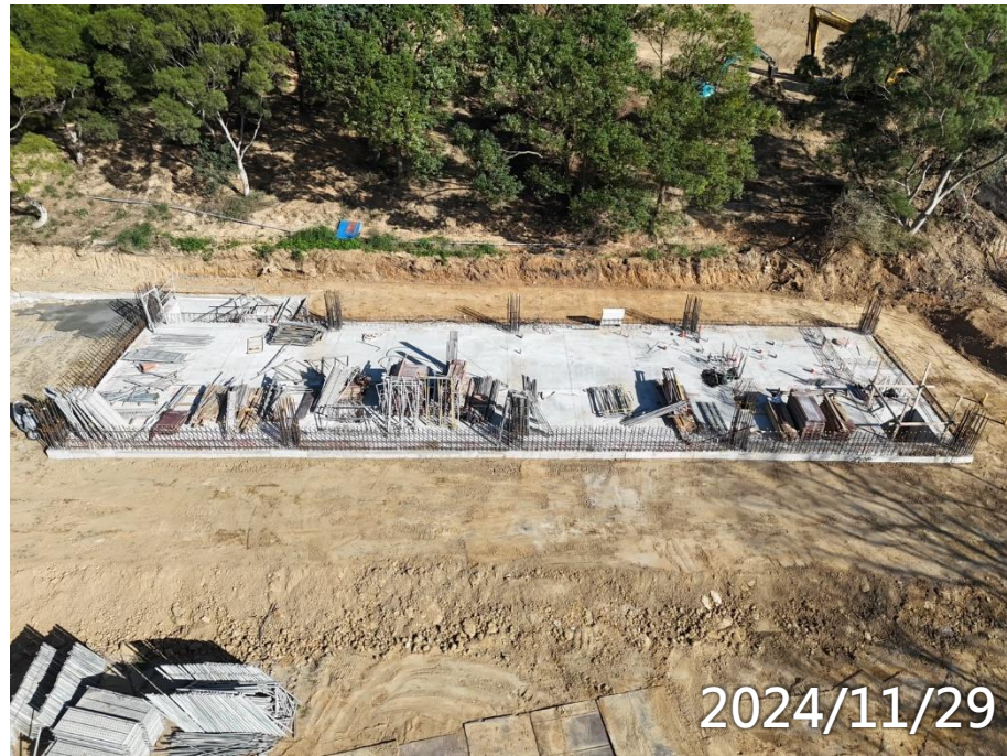
司機休息室土方回填細整
