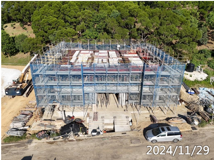
男常住3F梁版鋼筋模板水電施作
