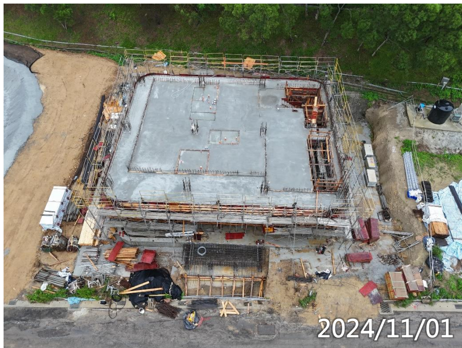
男常住2F梁版混凝土澆置
