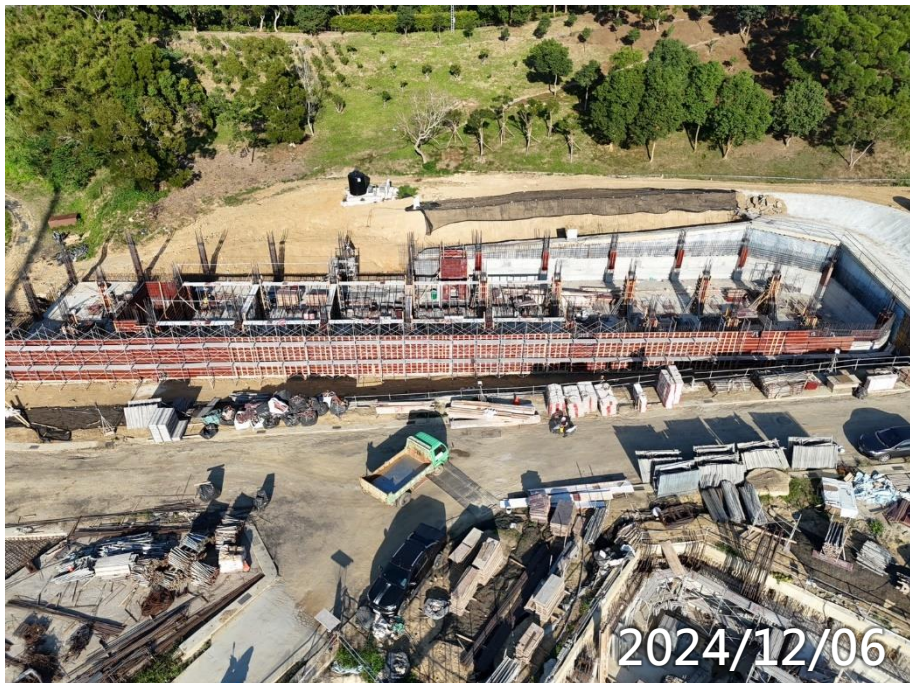
男寮B1F柱牆鋼筋模板水電施作
