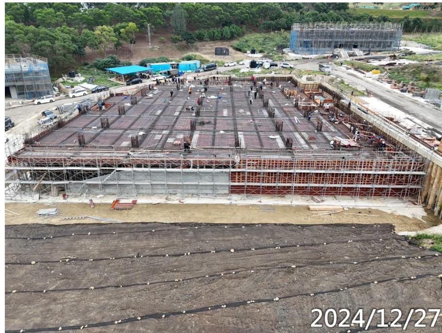
齋堂1F柱牆2F梁版施作
