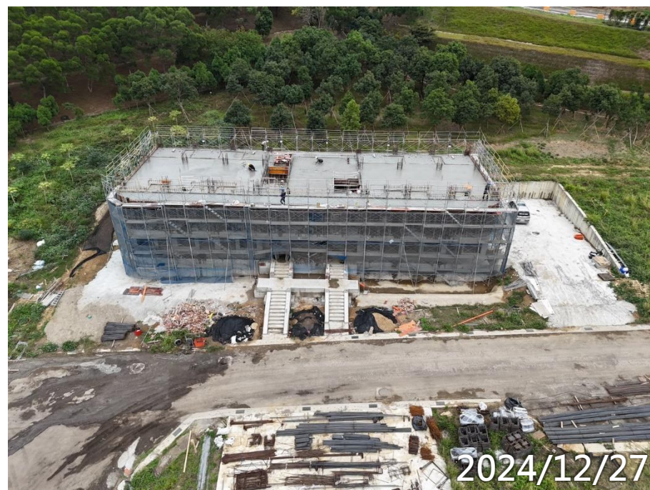
男義工2F柱牆3F梁版施作
