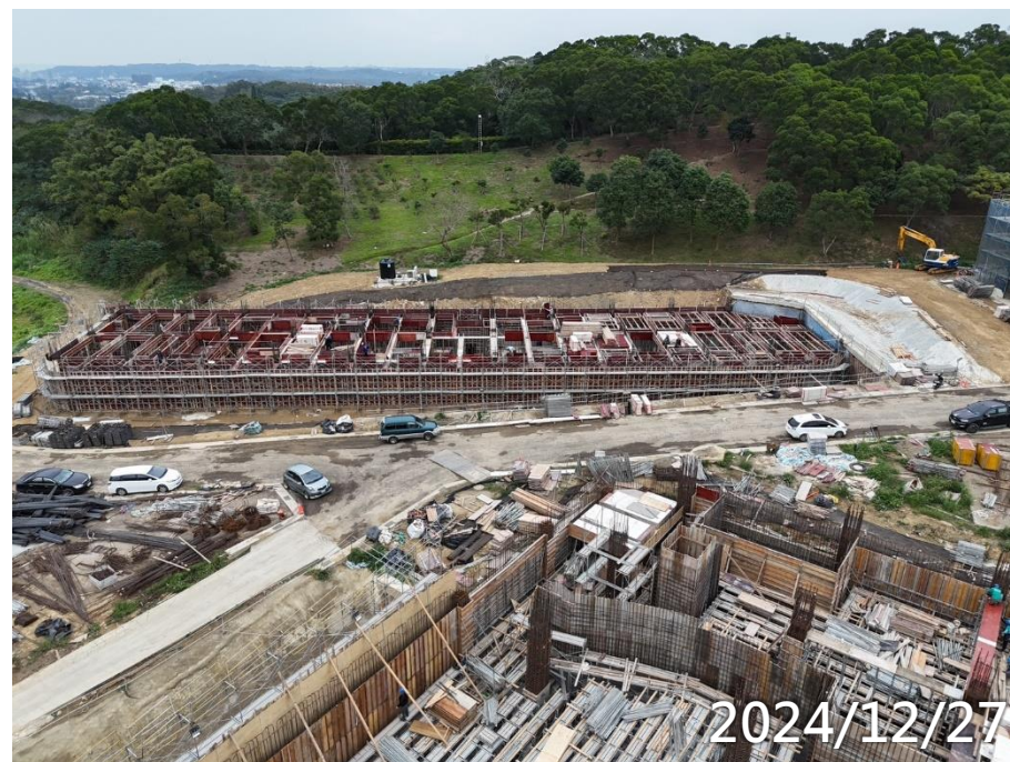
男寮B1F柱牆1F梁版施作
