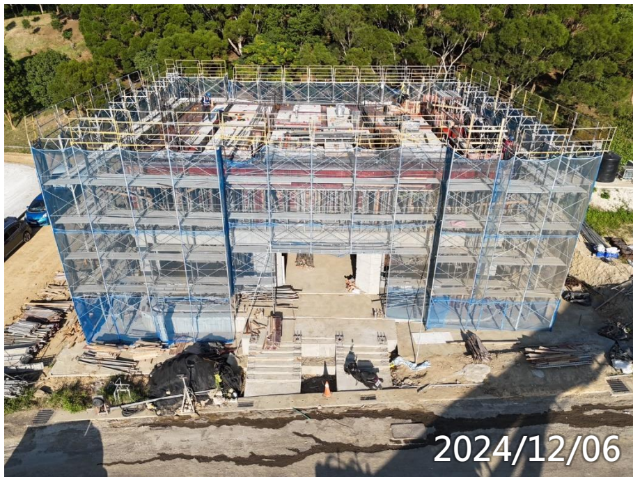
男常住3F梁版鋼筋模板水電施作
