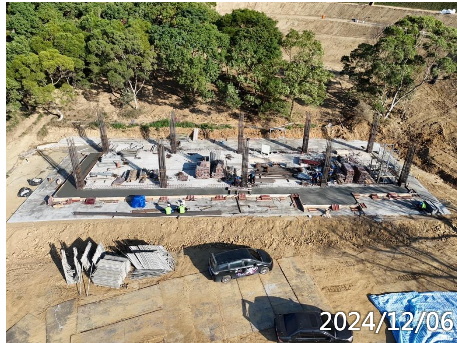
司機休息室1F柱牆鋼筋模板水電施作
