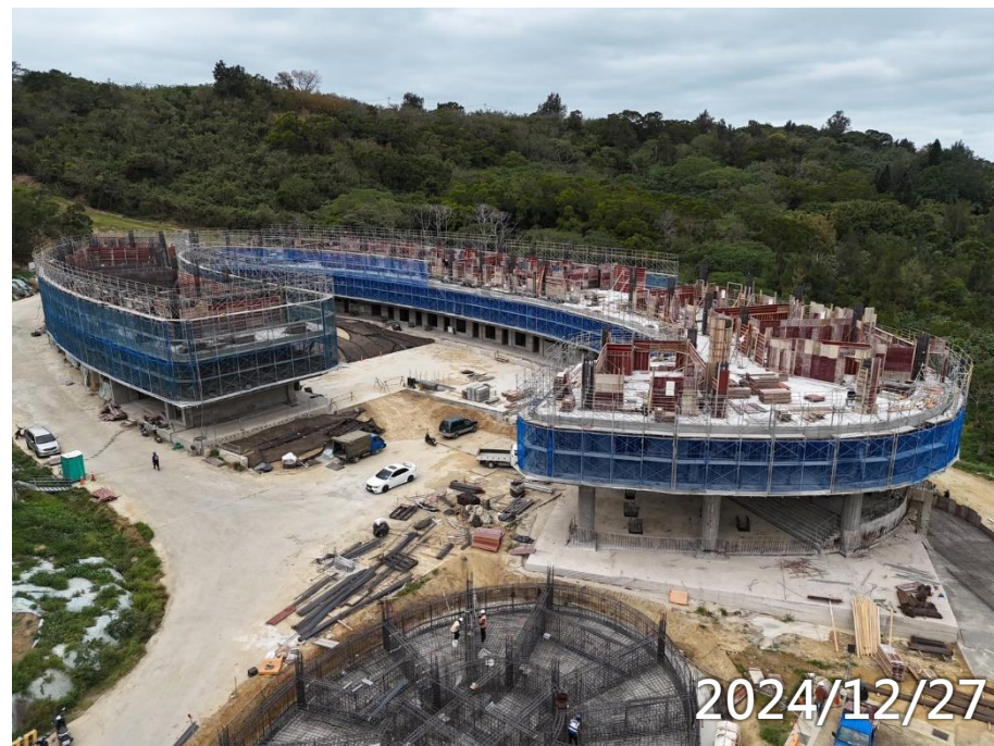
女寮3F柱牆施作
