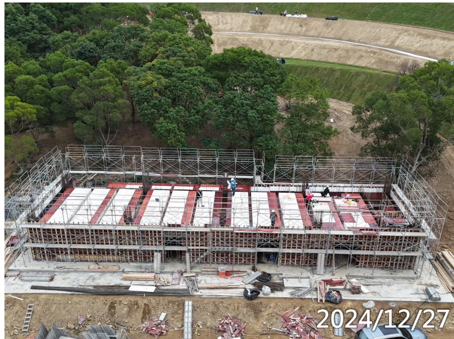
司機休息室1F柱牆2F梁版施作
