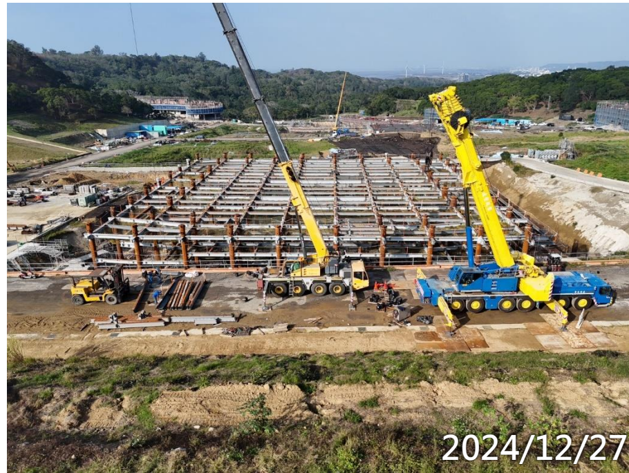
全區B1F至2F鋼構吊裝
