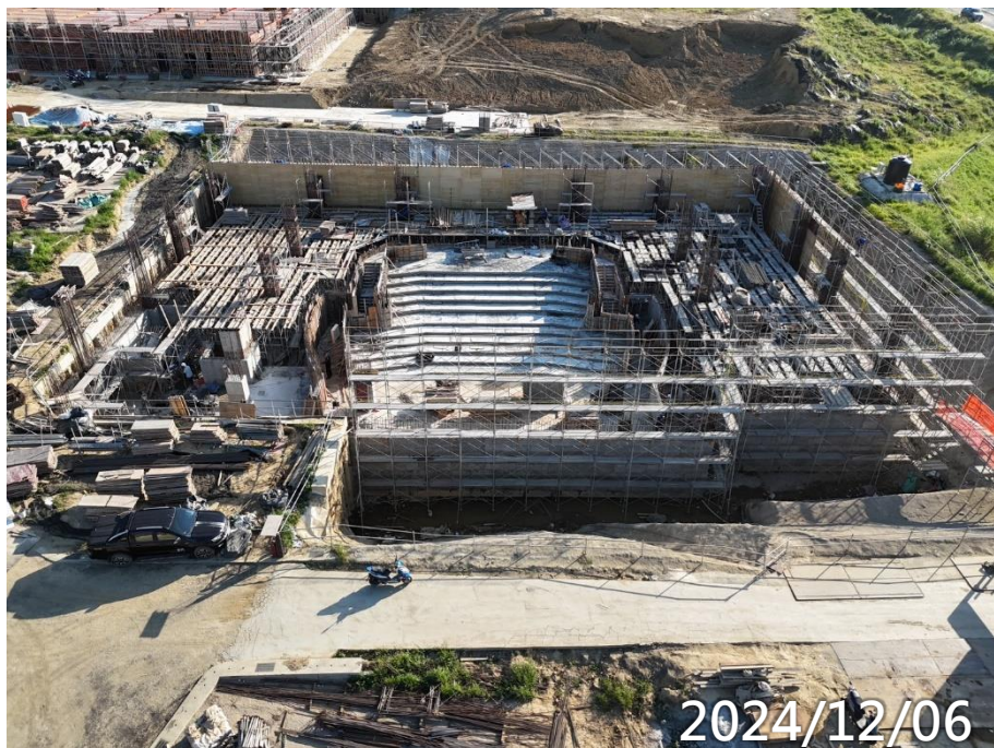
玄文B1F柱牆鋼筋模板水電施作
