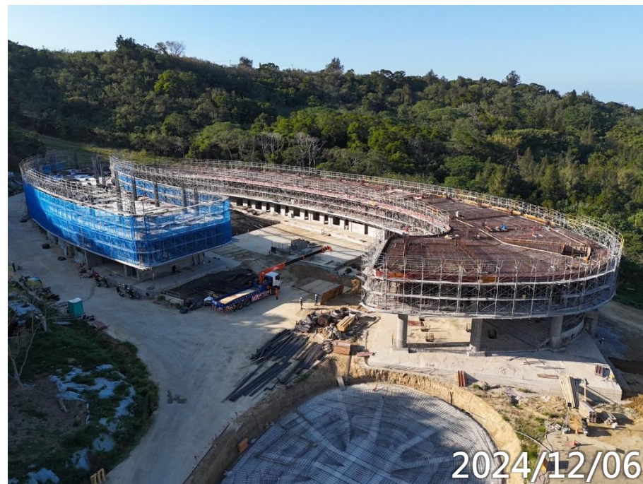
女寮2F柱牆3F梁版鋼筋模板水電施作
