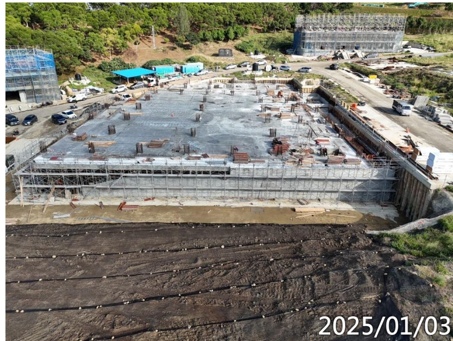
齋堂1F柱牆2F梁版澆置
