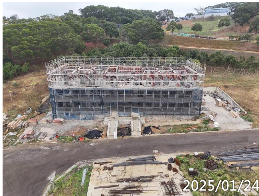
男義工3F柱牆RF梁施作
