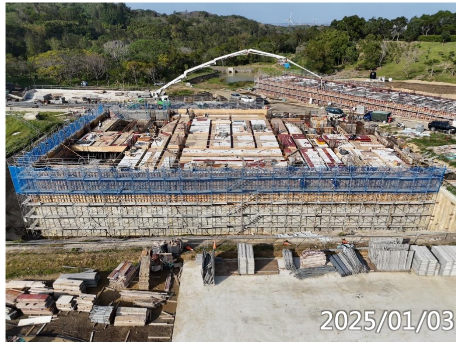
玄文B1F柱牆1F梁版施作
