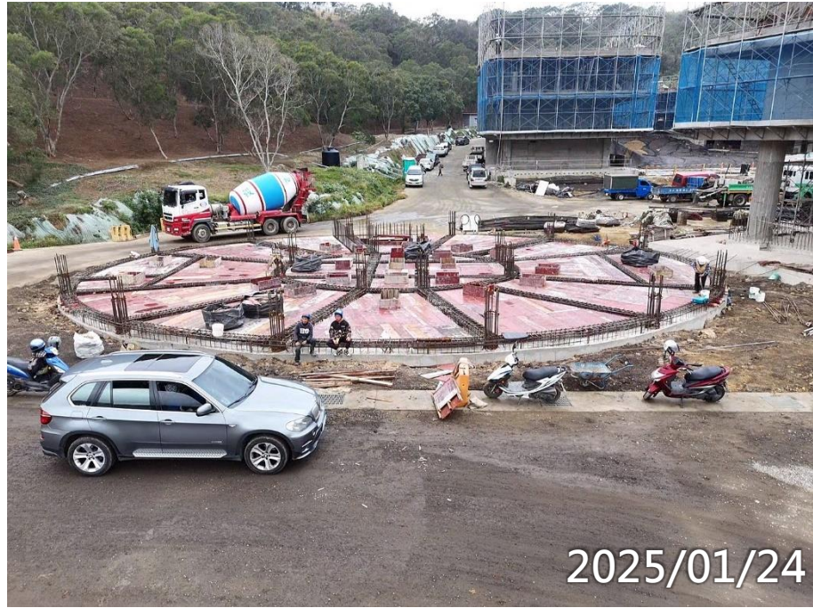
女常住基礎層施作
