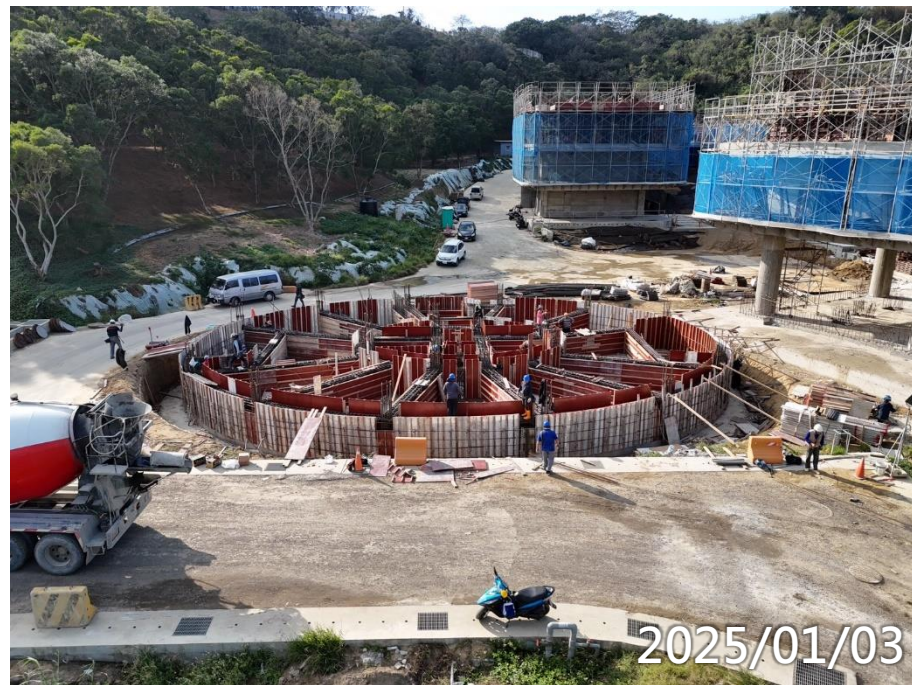
女常住筏基層施作
