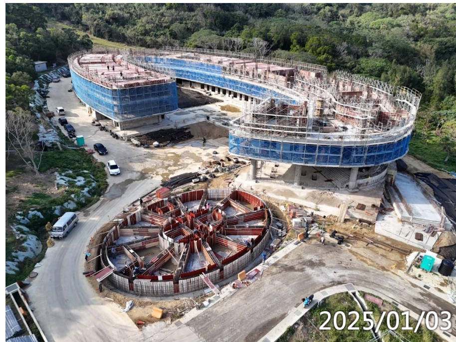
女寮3F柱牆4F梁版施作
