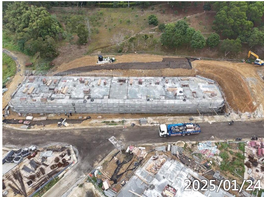
男寮B1F外牆拆模 鋼軌樁樁帽打除
