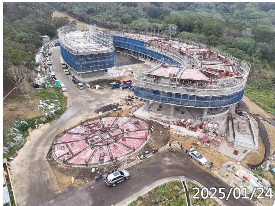
女寮3F柱牆4F梁版澆置(南區) 3F柱牆4F梁版施作(北區)
