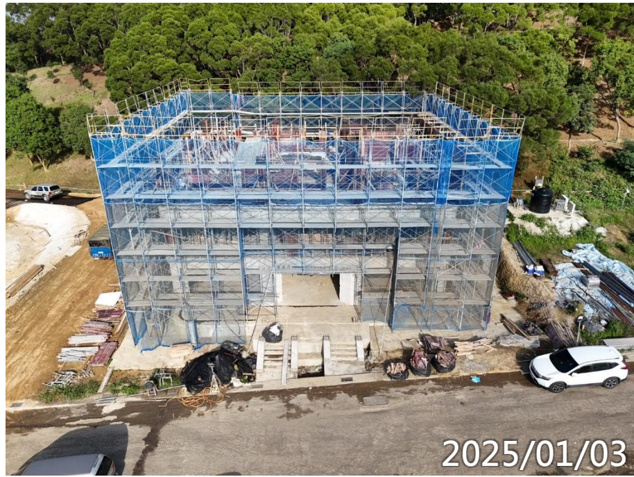
男常住3F柱牆施作
