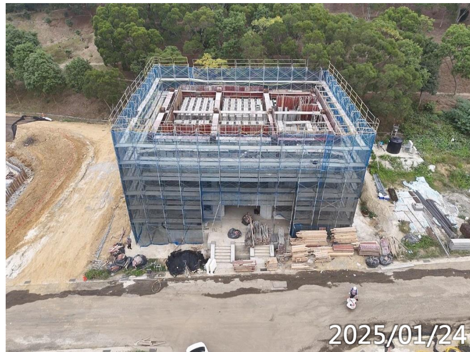
男常住3F柱牆RF梁施作
