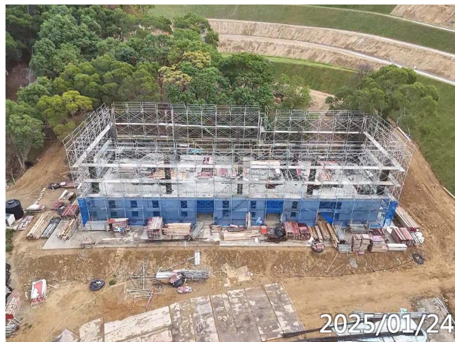
司機休息室2F柱施作
