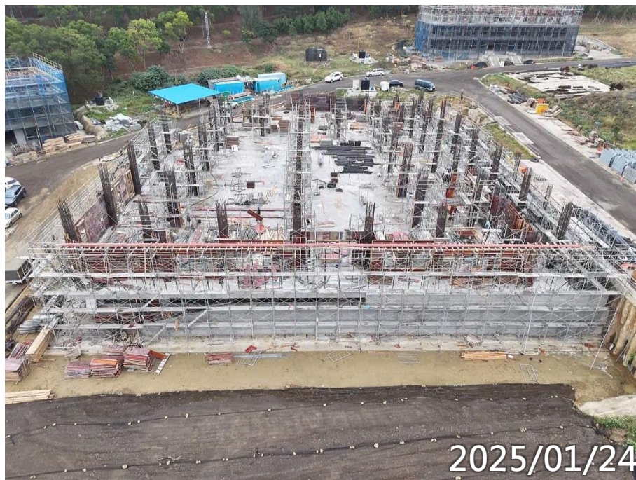
齋堂2F柱牆施作
