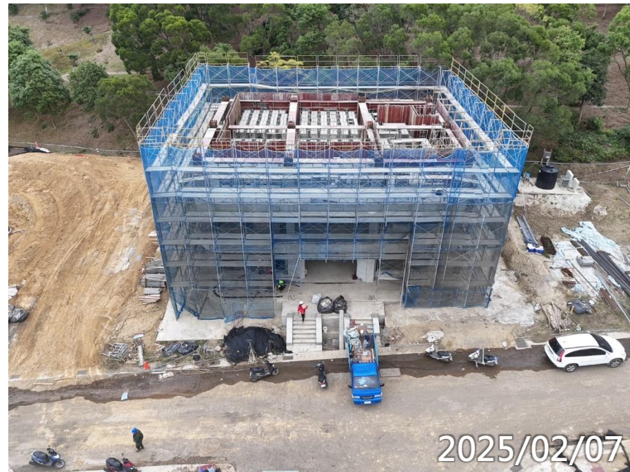
男常住3F柱牆RF梁施作
