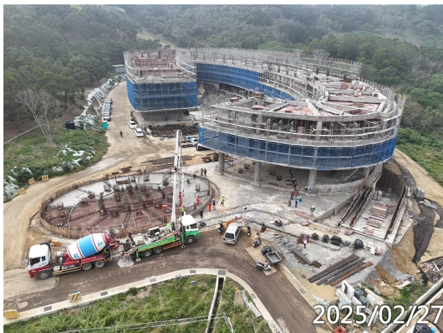
4F柱牆鋼筋模板水電施作 鋼構預埋
