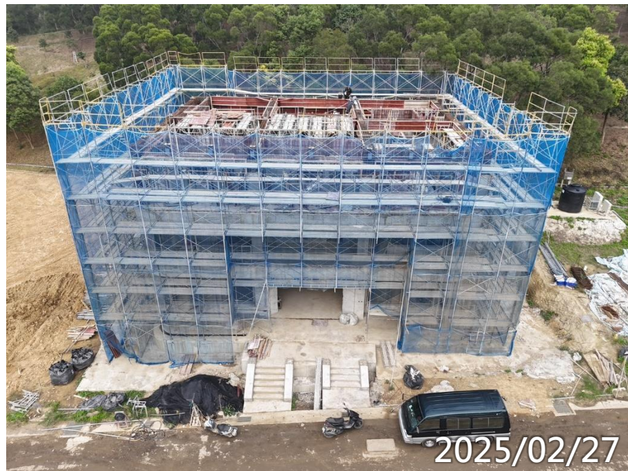
RF梁鋼筋模板水電施作
