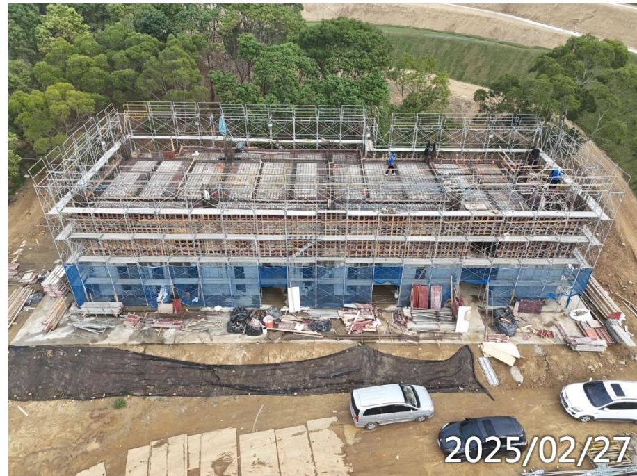
3F梁版鋼筋模板水電施作
