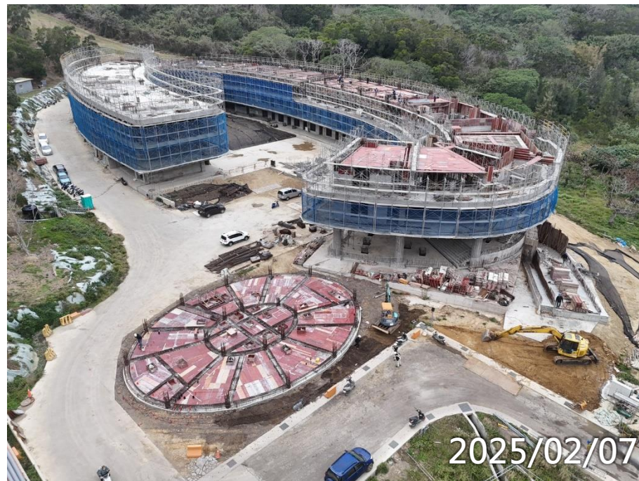
女寮3F柱牆4F梁版施作(北區)
