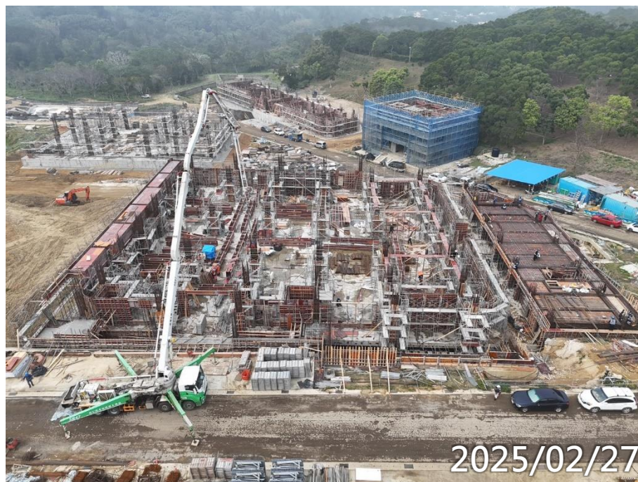
2F柱牆、3F梁版 鋼筋模板水電施作
