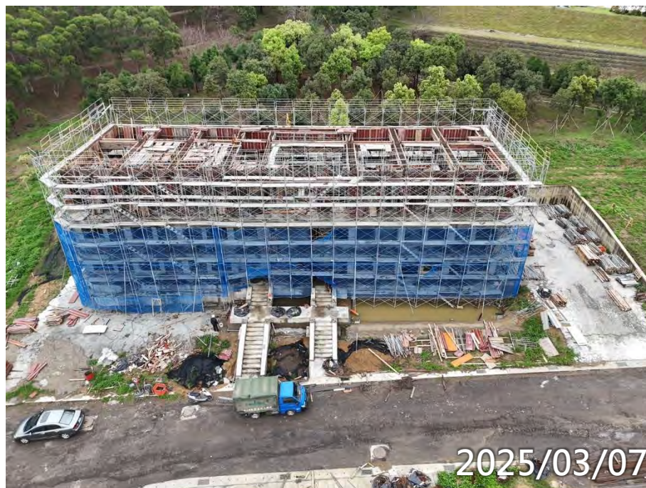
RF梁鋼筋模板水電施作 鋼構預埋
