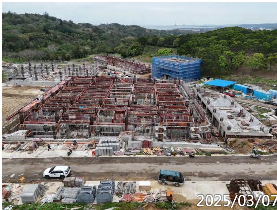
2F-4F柱牆、4F梁版 鋼筋模板水電施作
