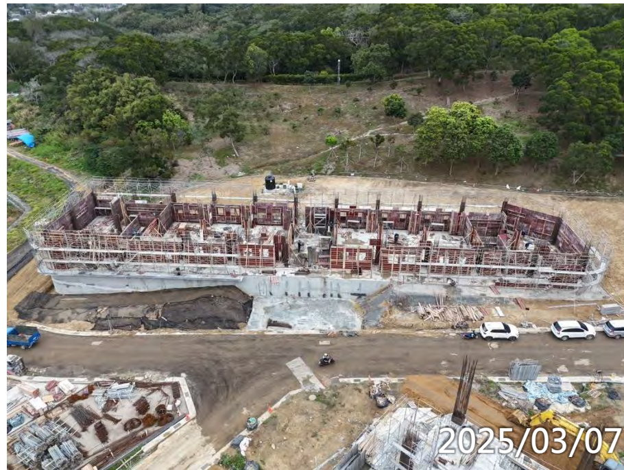
1F柱牆、2F梁版 鋼筋模板水電施作
