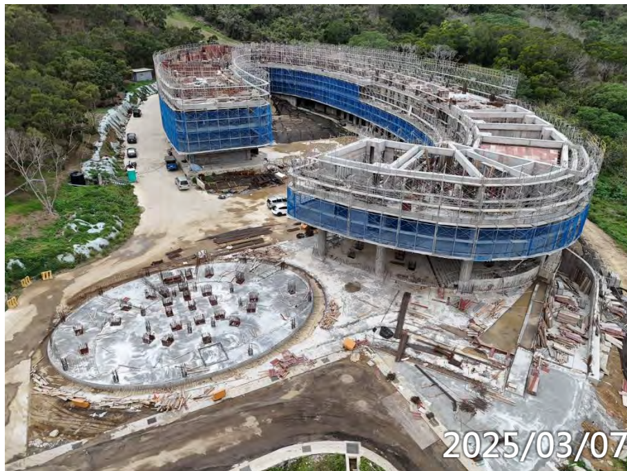
4F柱牆、車道 鋼筋模板水電施作
