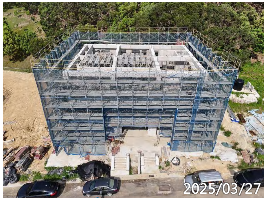
1F、2F梁底、螺桿清理 屋頂待鋼構吊裝
