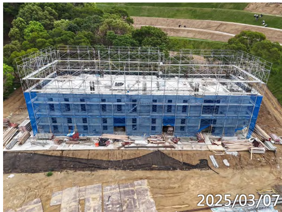
3F梁版澆置
