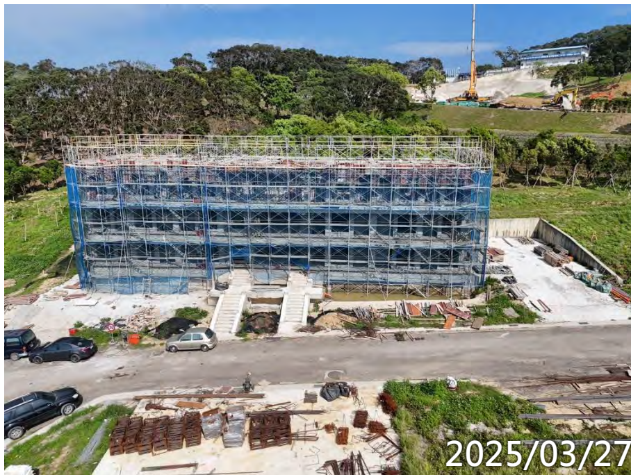
RF梁澆置 屋頂待鋼構吊裝
