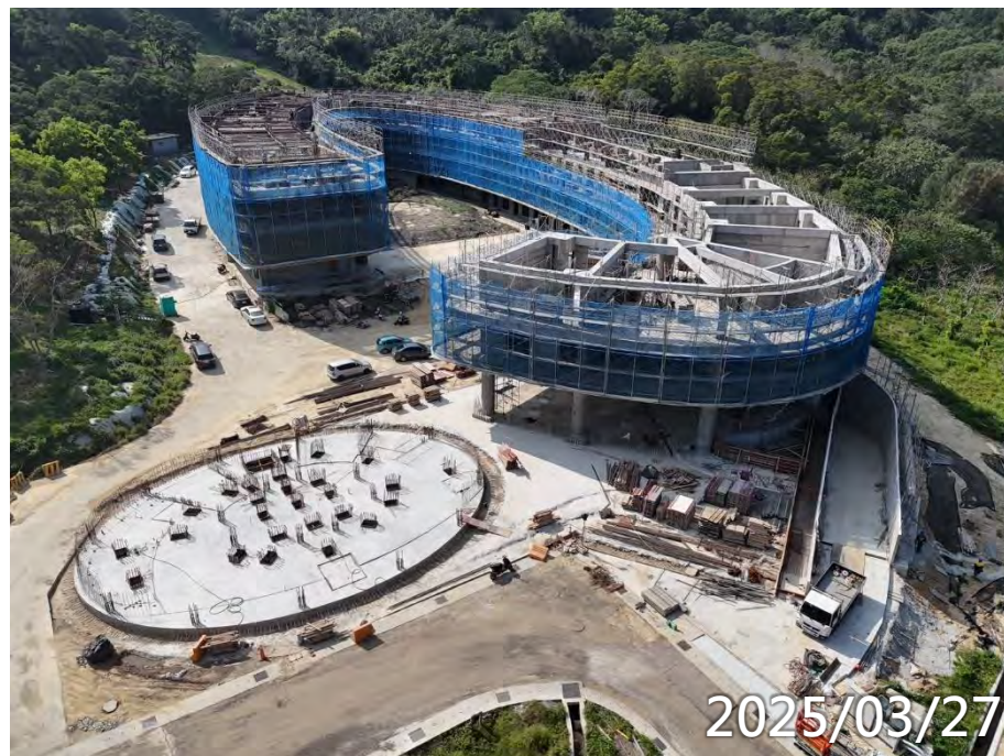
4F柱牆鋼筋模板水電施作 B1F泥作吊線
