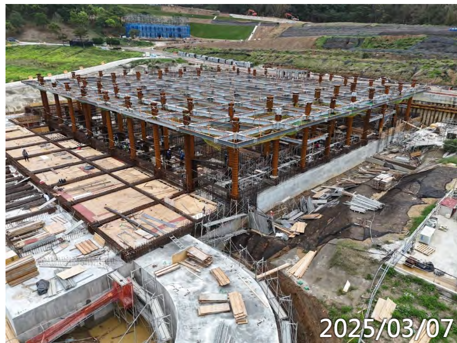
高版區地梁、低版區1F梁版、 車道牆鋼筋模板水電施作
