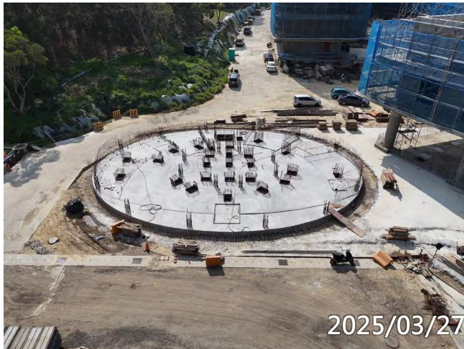
1F柱牆施作 筏基拆模
