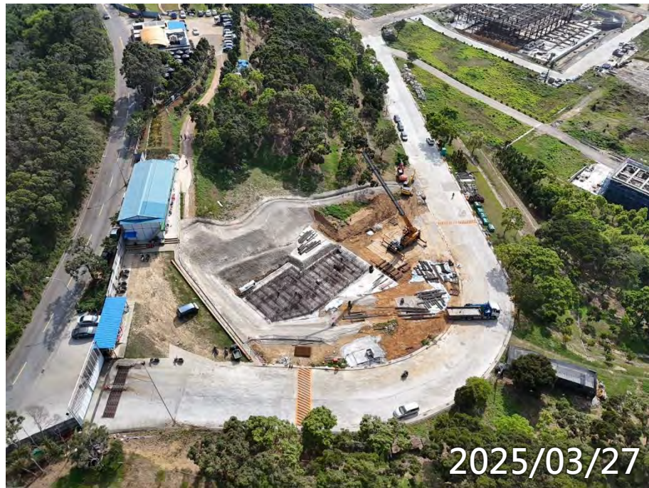
筏基層鋼筋水電施作
