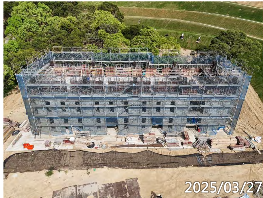
3F柱牆鋼筋模板水電施作
