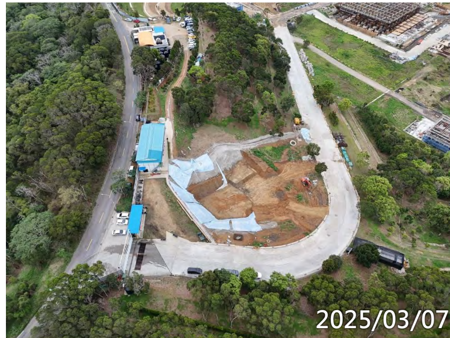
土方開挖、噴漿護坡
