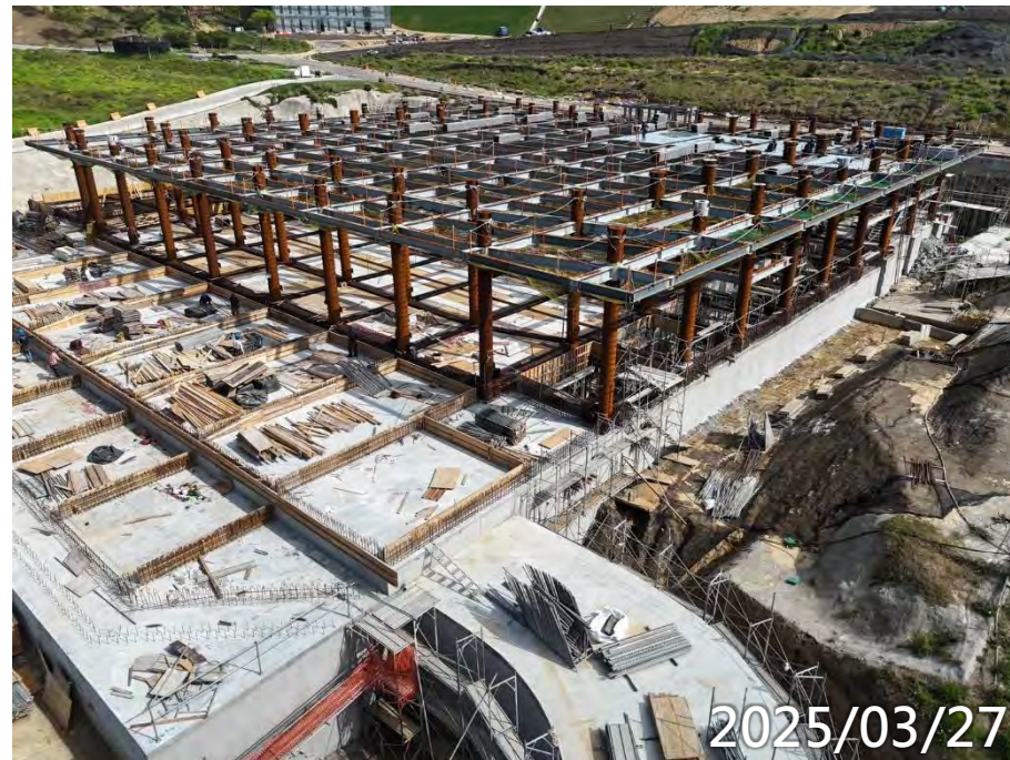
高版區1MF、2F鋼承鈹施作 低版區1F梁版鋼筋模板水電施作
