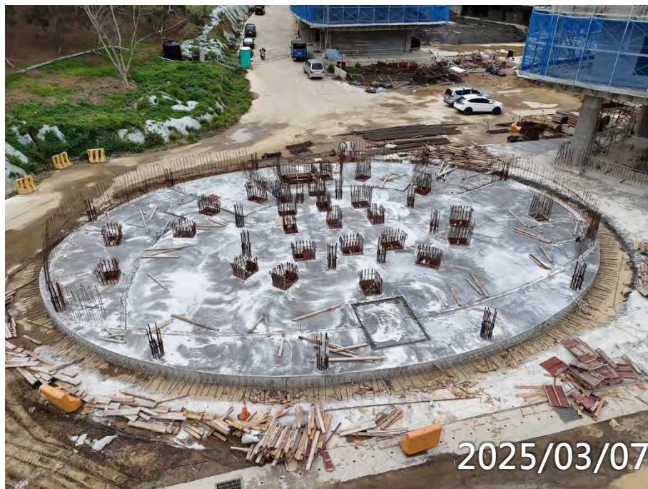
1F柱牆施作
