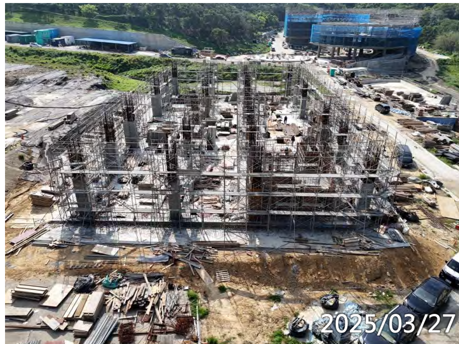
1F柱牆鋼筋模板水電施作
