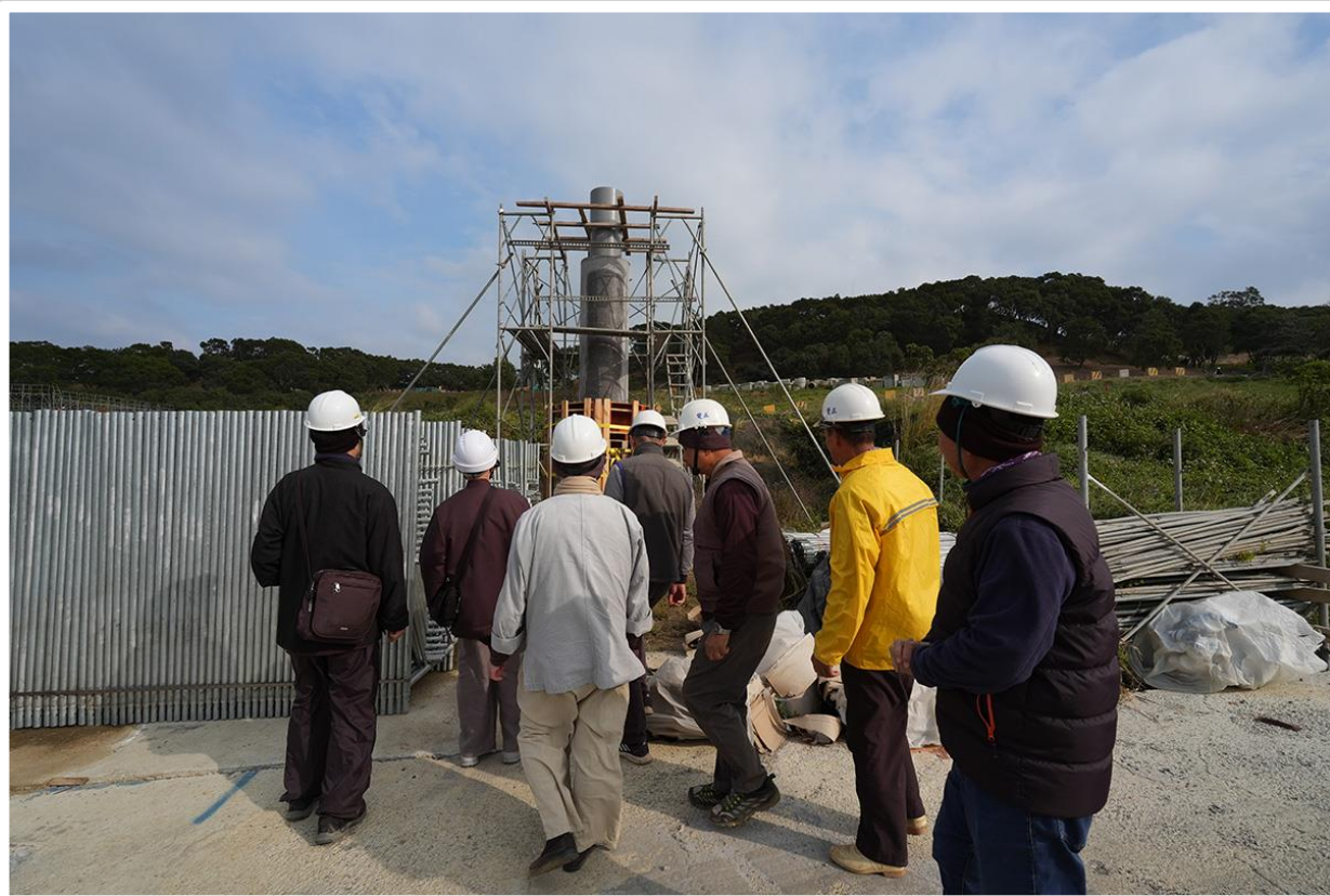
查看主殿磨石子柱試作狀況 2024/12/22
