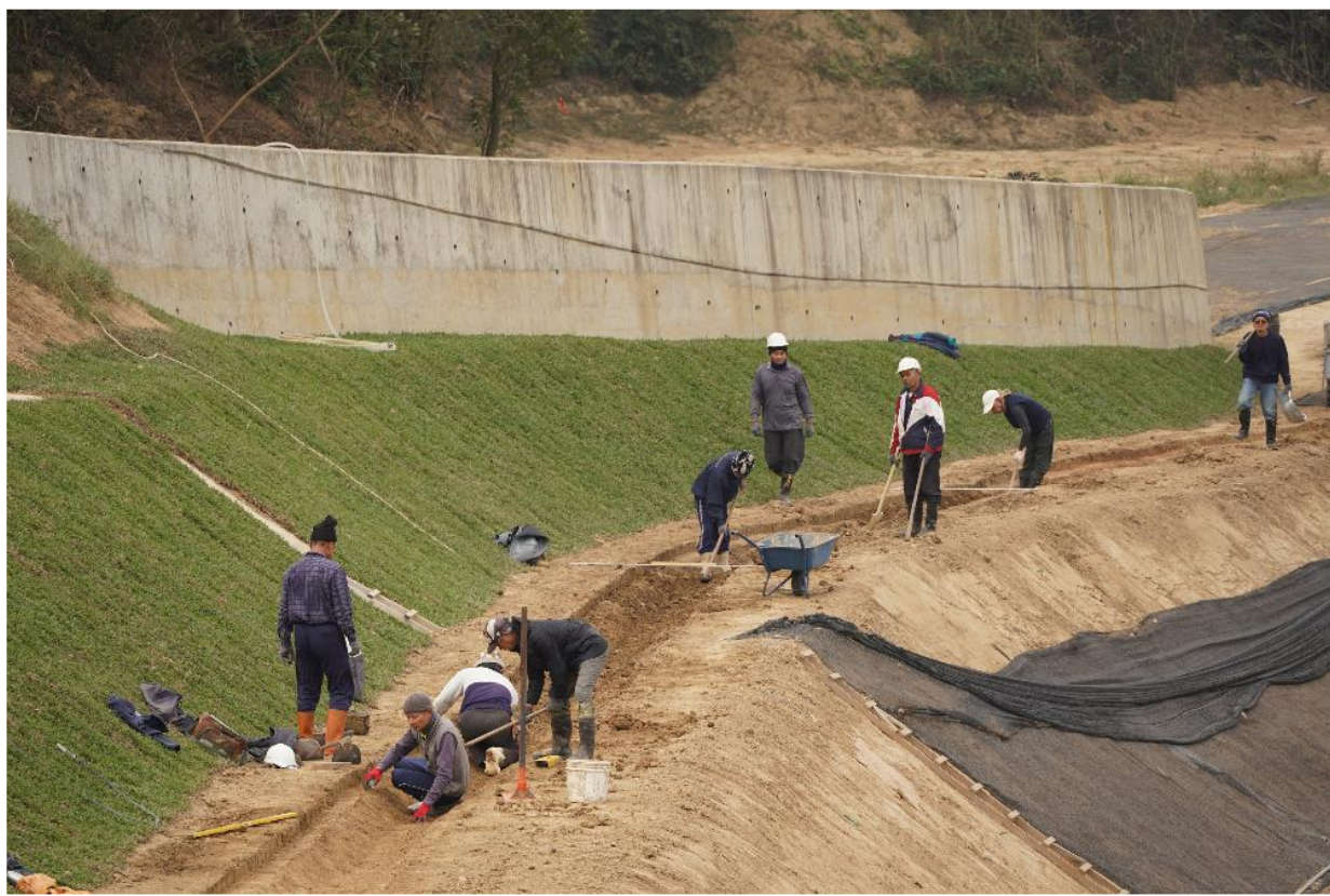
義工施作回填區排水溝 2024/12月
