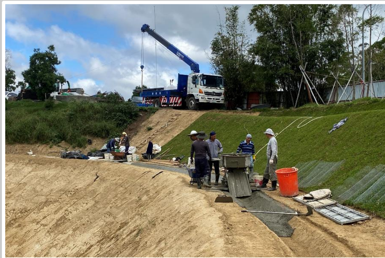
義工施作回填區排水溝 2024/12月
