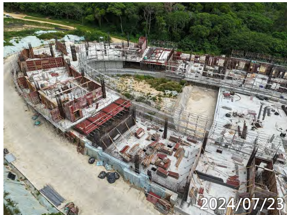
女寮2區2F柱牆鋼筋模板水電施作 防颱作業
