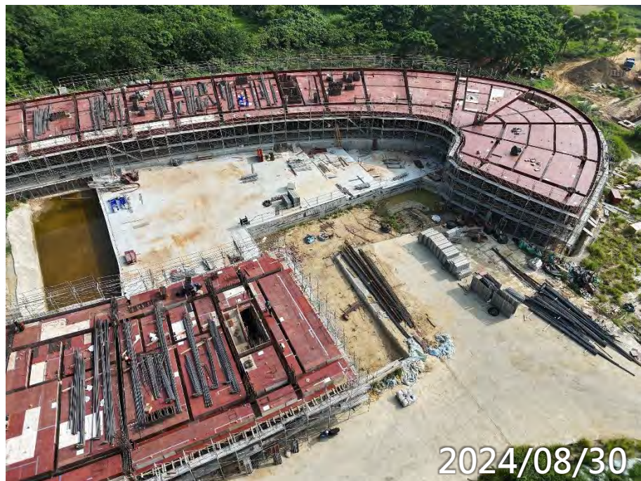
女寮1、3區2F梁版鋼筋模板水電施作
