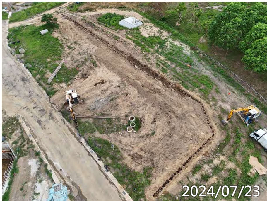
男寮鋼軌樁打設
