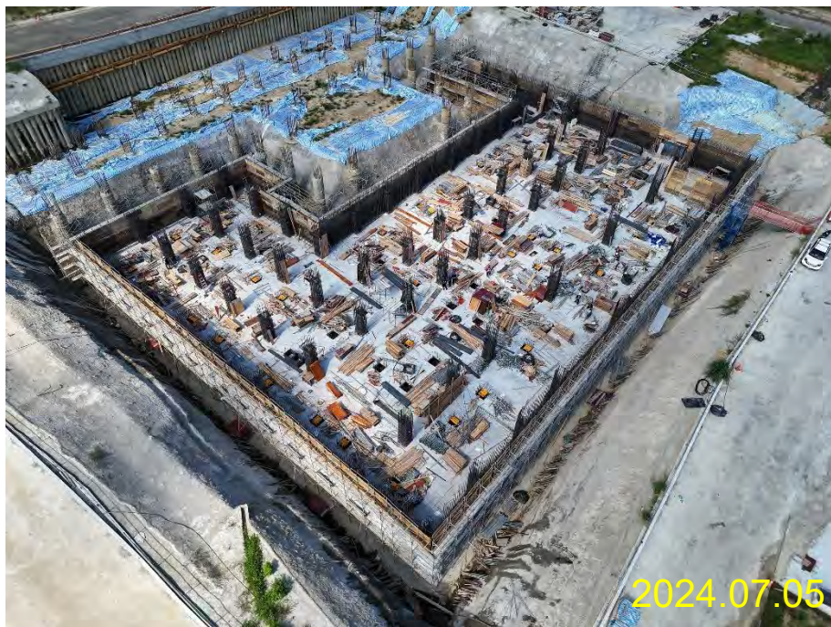
主殿B2F鋼筋模板、機電施作
