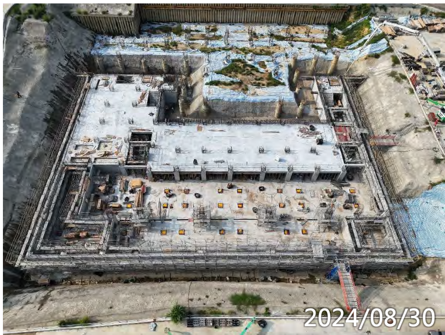
主殿1區B1F梁版混凝土澆置
