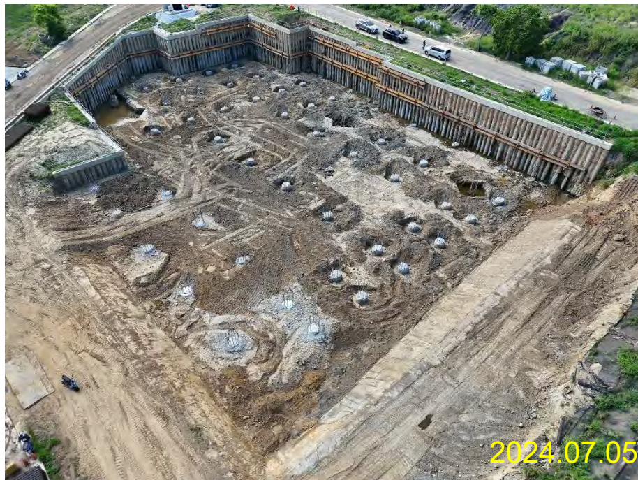
齋堂第三層土方開挖細整、樁頭劣質打除
