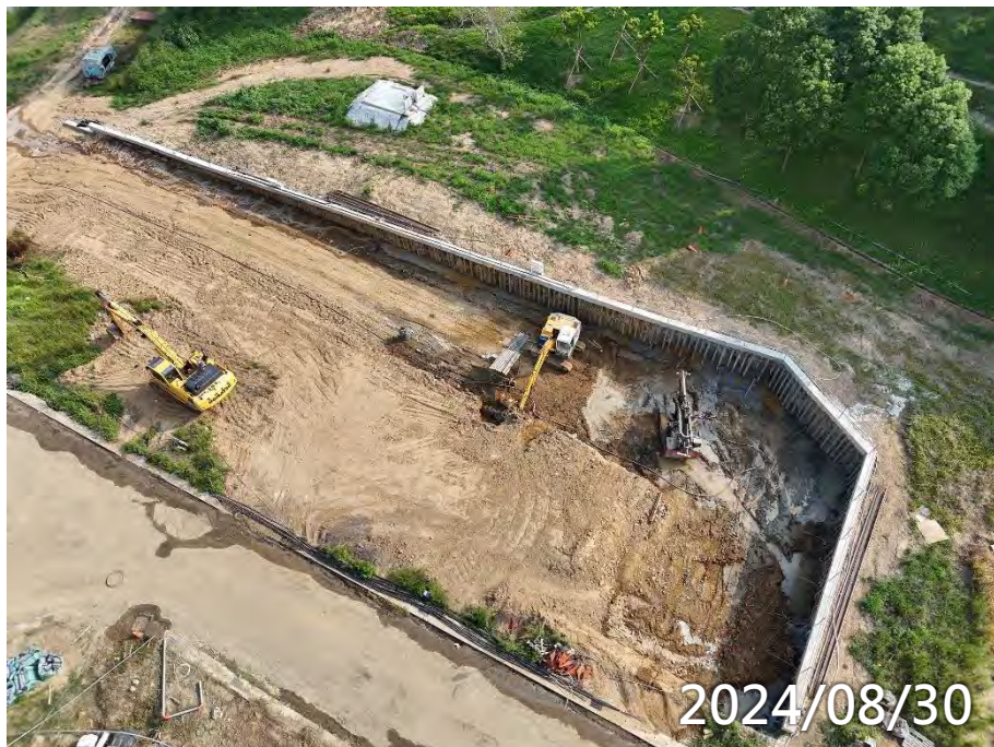
男寮地錨試錨、第一階土方開挖
