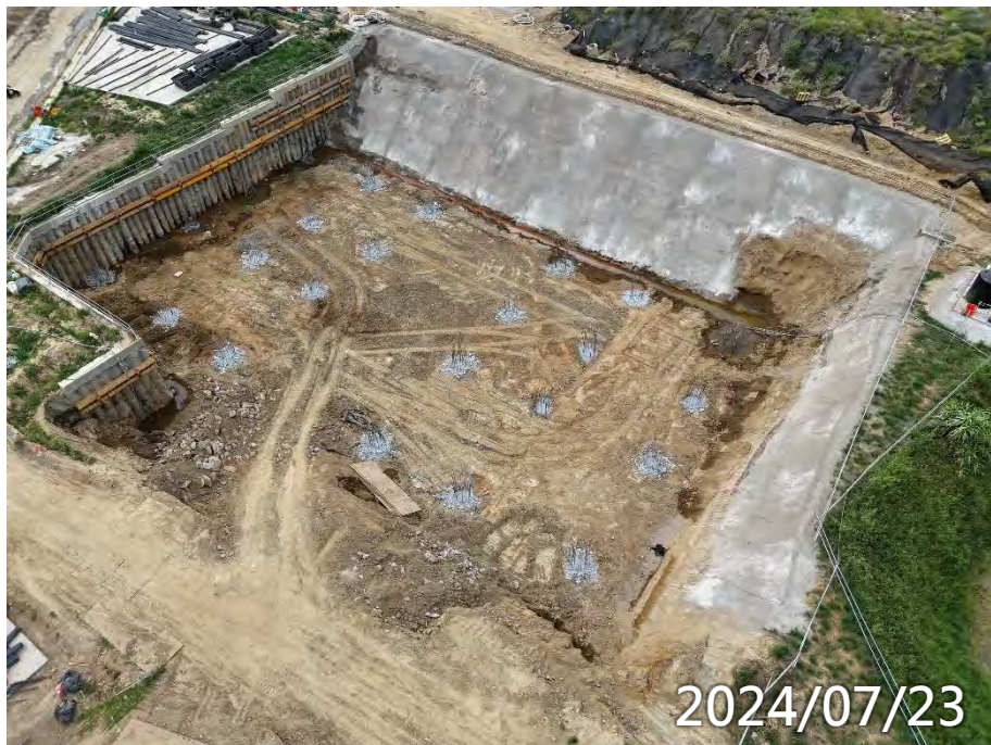
玄文第三階土方開挖、噴漿護坡、 接地施作
