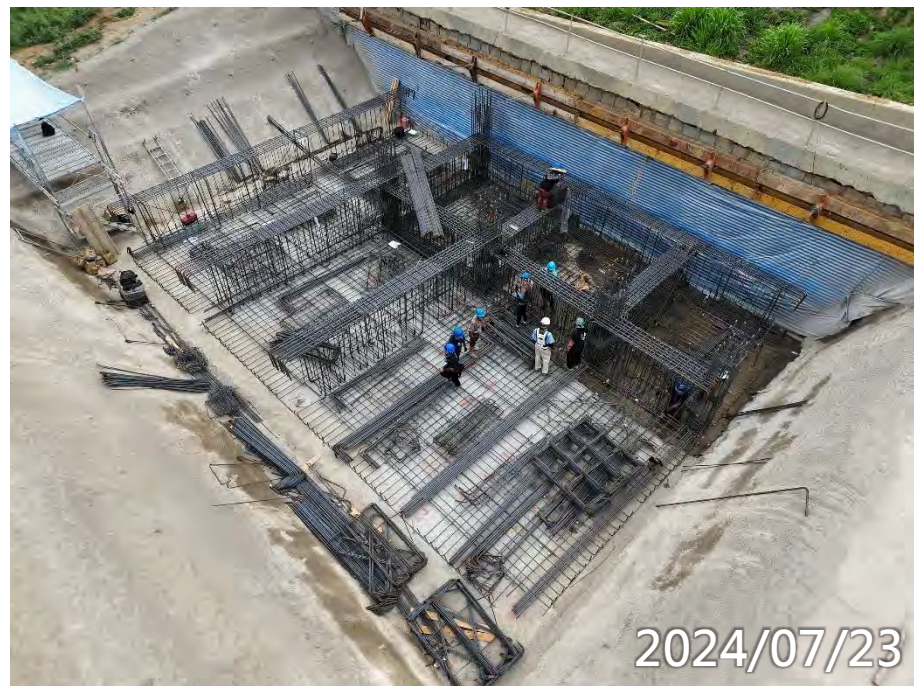
男義工基礎層鋼筋綁紮
