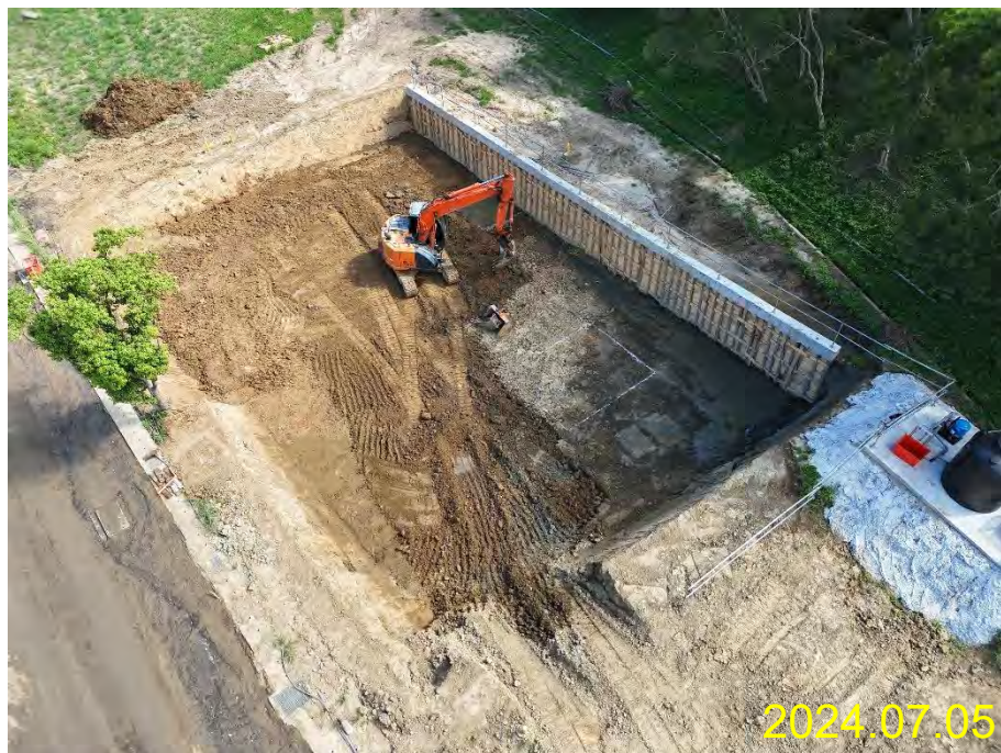
男常住機電接地、土方細整、噴漿護坡
