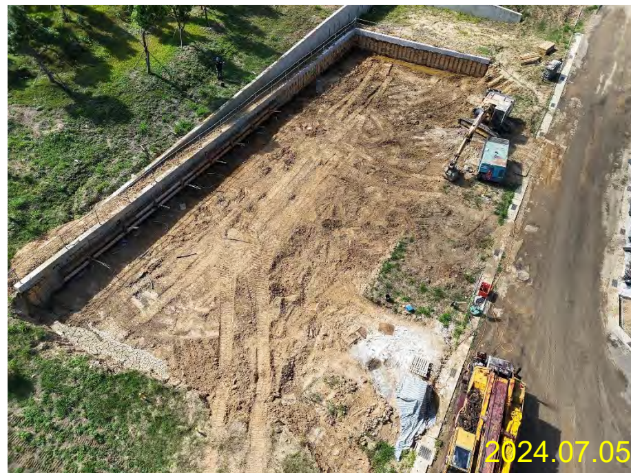
男義工地錨施預力完成、第二階土方開挖
