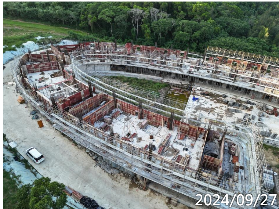
女寮2區2F柱牆鋼筋模板水電施作
