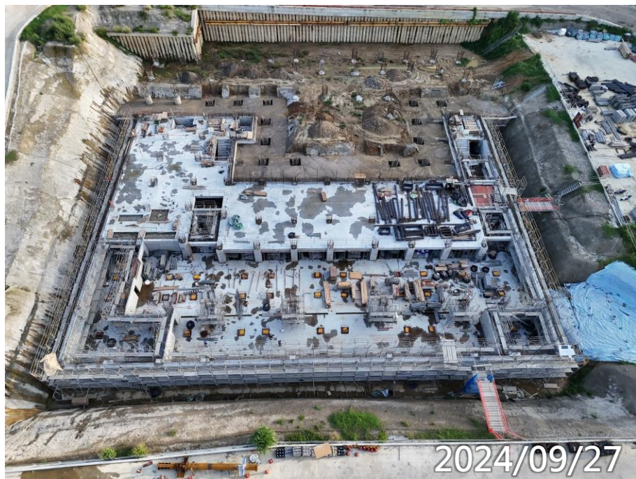
主殿高版CLSM回填、樁頭劣質打除
