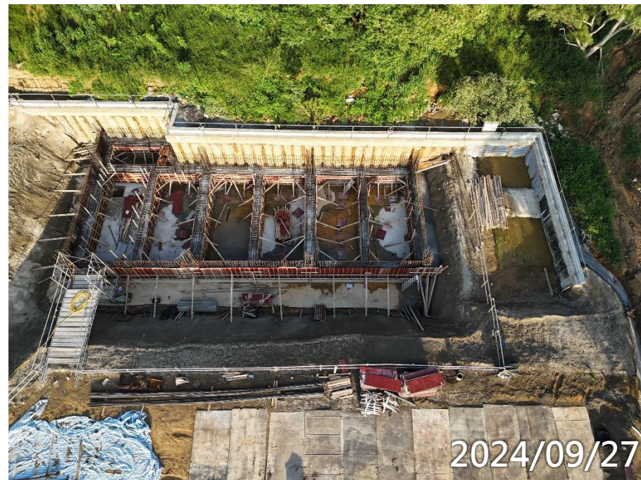
司機休息室基礎層鋼筋模板水電施作
