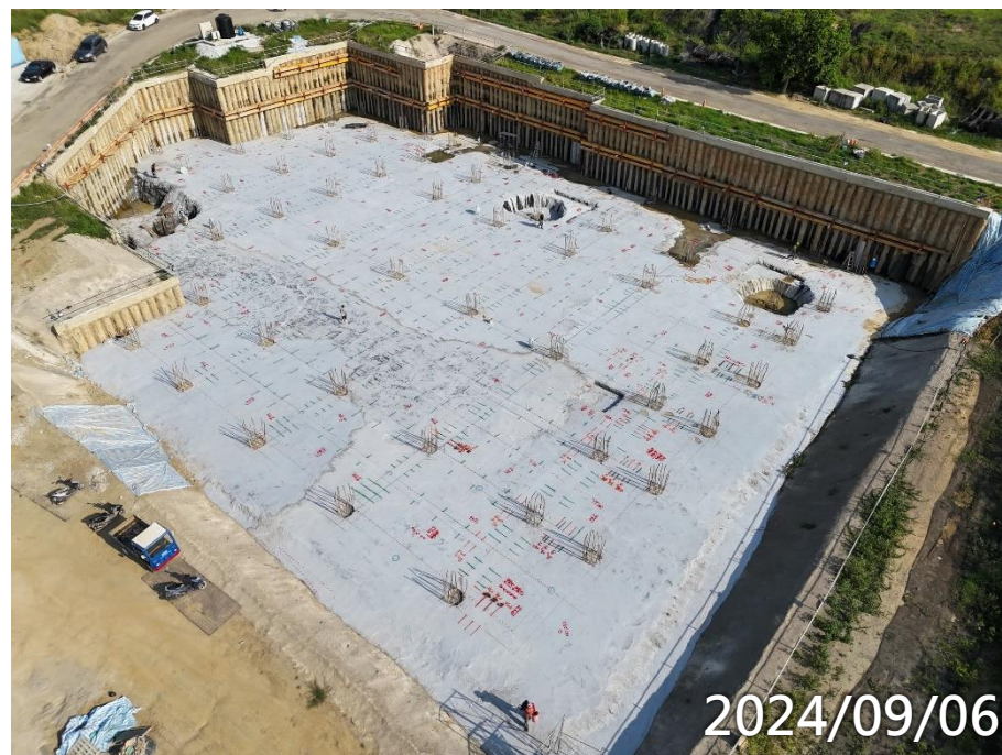
齋堂基礎層鋼筋水電放樣
