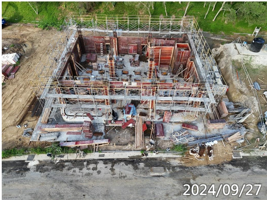
男常住1F柱牆鋼筋模板水電施作
