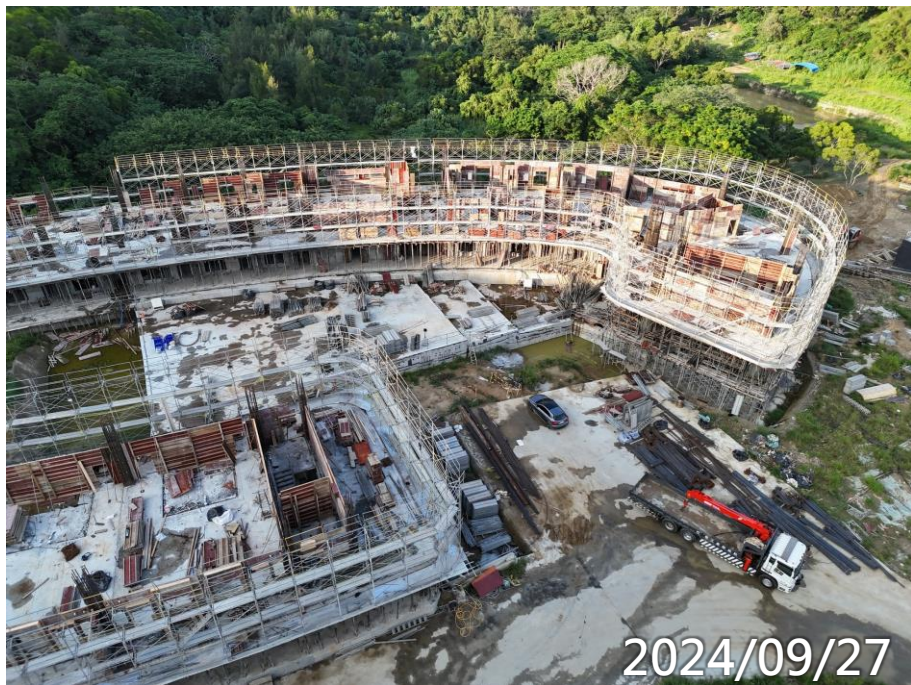
女寮1、3區2F柱牆鋼筋模板水電施作
