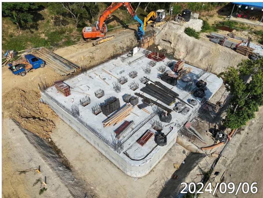
男常住鋼軌樁拆除、土方回填
