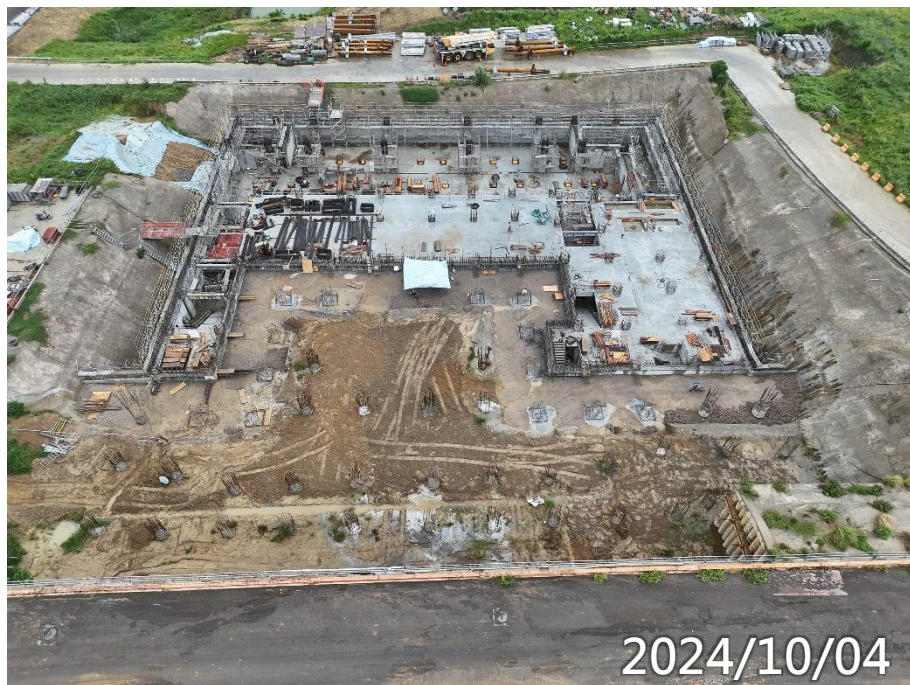
主殿高版CLSM回填、樁頭劣質打除
