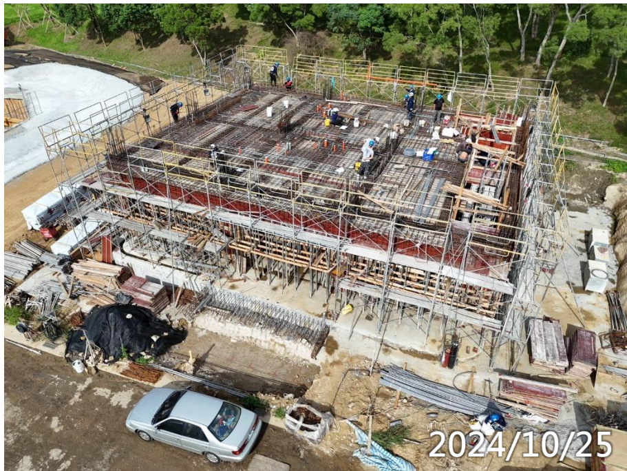
男常住2F梁版鋼筋模板水電施作
