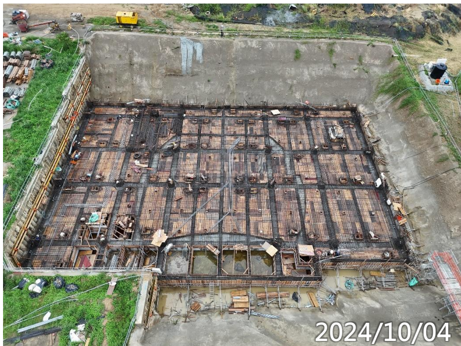
玄文BS版鋼筋模板水電施作
