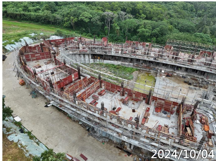
女寮2F柱牆鋼筋模板水電施作
