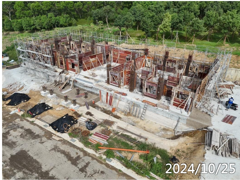
男義工1F柱牆鋼筋模板水電施作
