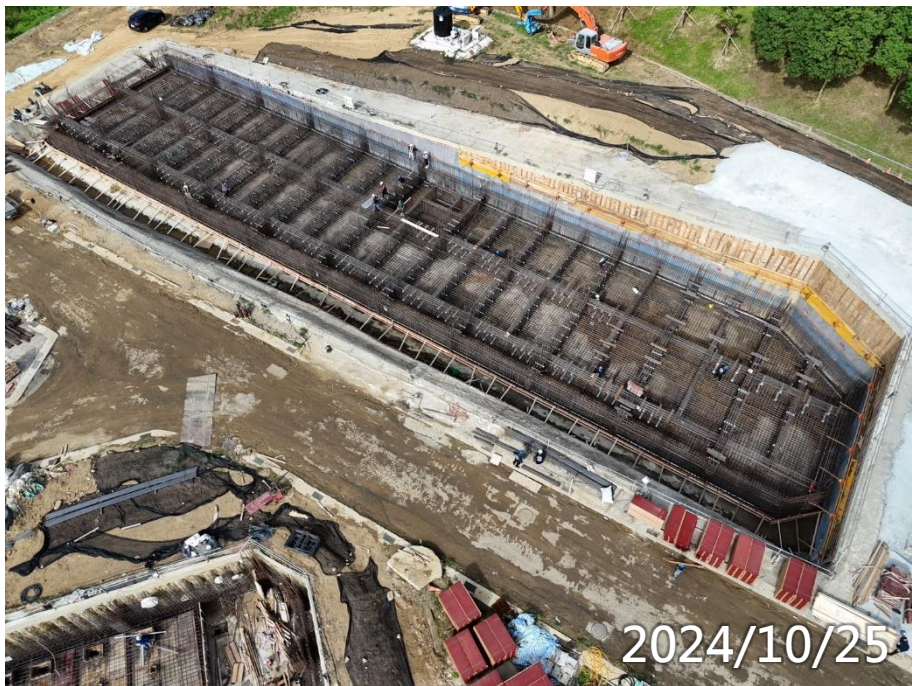
男寮基礎層鋼筋模板水電施作
