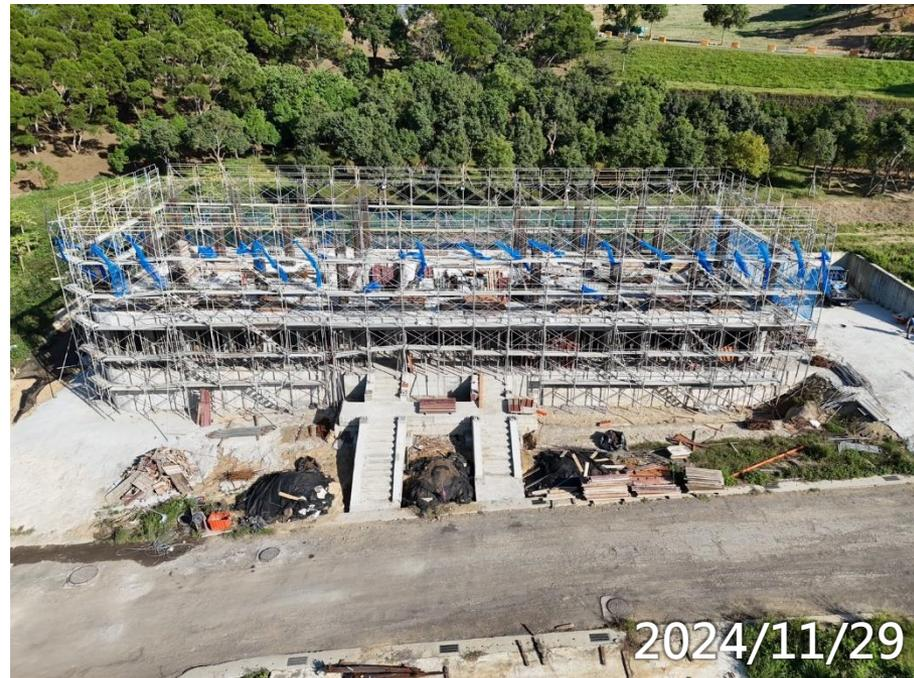
男義工2F柱牆鋼筋模板水電施作
