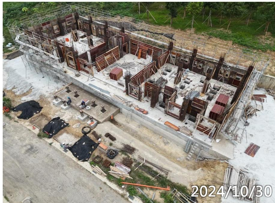
男義工1F柱牆鋼筋模板水電施作
