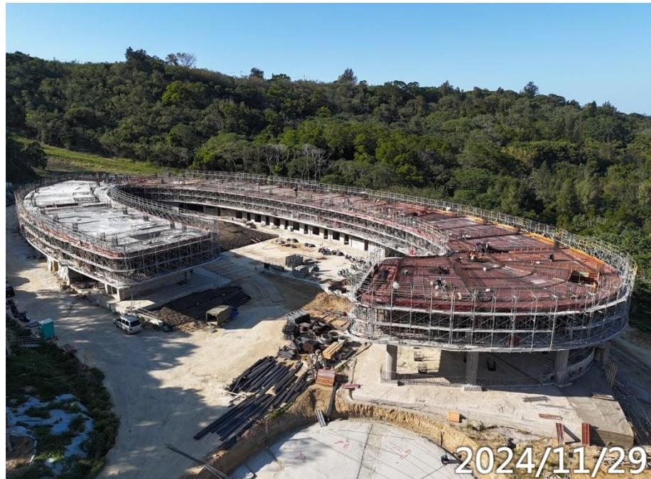
玄文B1F柱牆鋼筋模板水電施作
