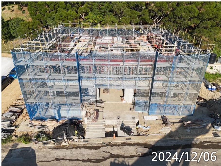
男常住3F梁版鋼筋模板水電施作
