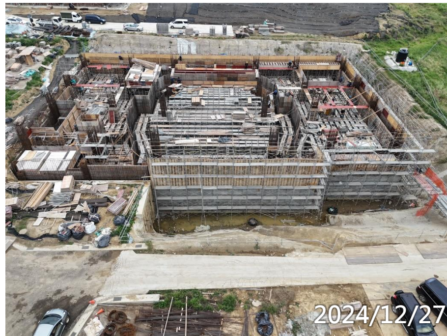
玄文B1F柱牆1F梁版施作
