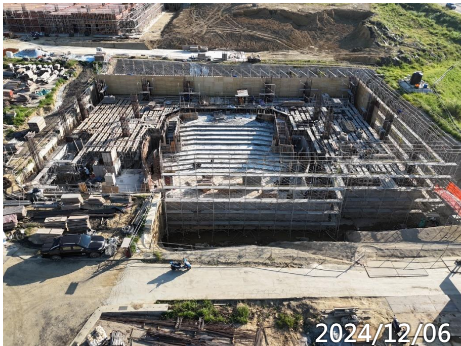
玄文B1F柱牆鋼筋模板水電施作
