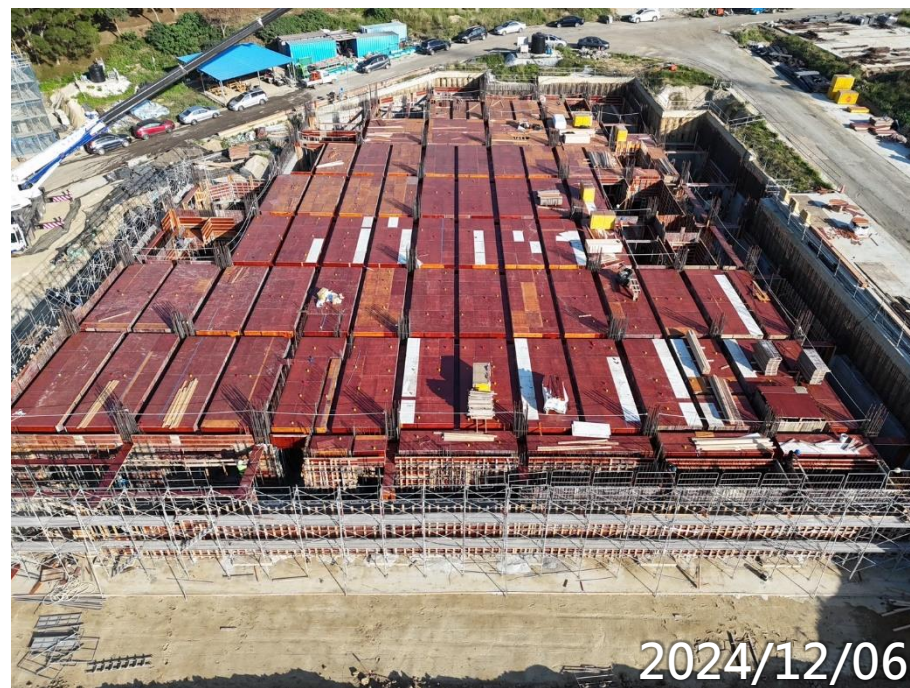
齋堂1F柱牆、2F梁版鋼筋模板水電施作
