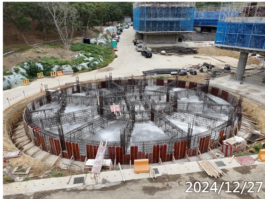
女常住筏基層施作
