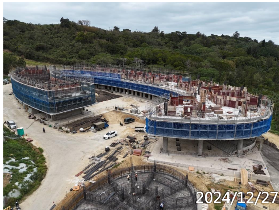
女寮3F柱牆施作
