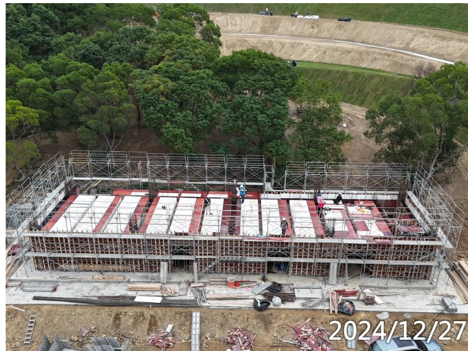
司機休息室1F柱牆2F梁版施作
