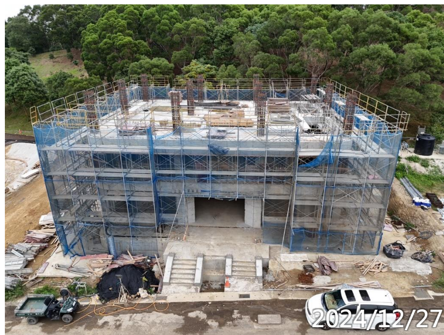
男常住3F柱牆施作
