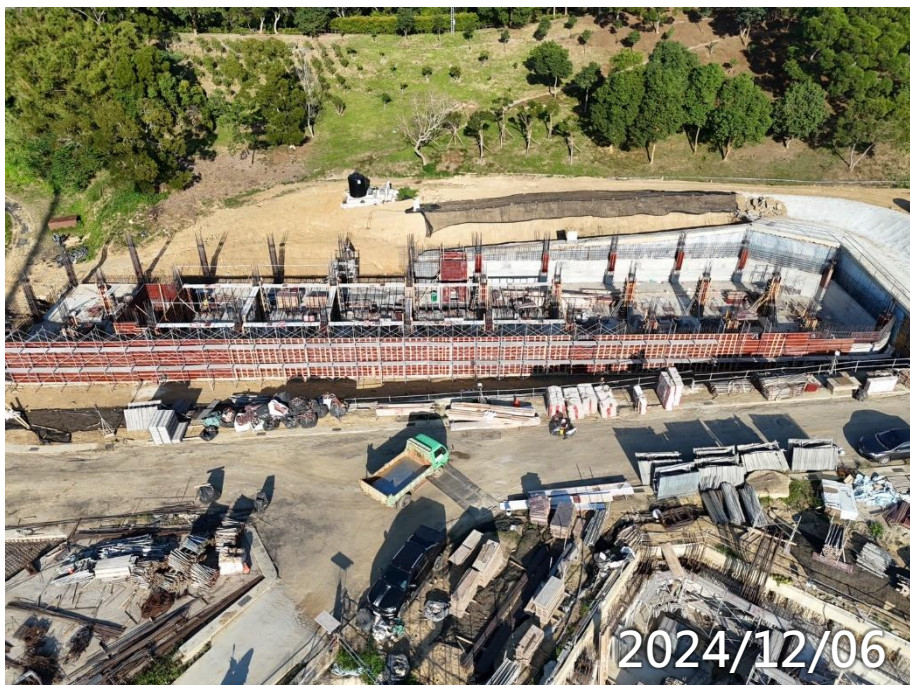
男寮B1F柱牆鋼筋模板水電施作
