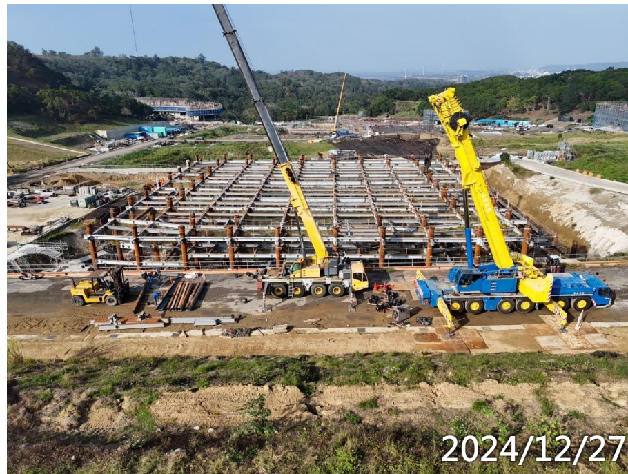
全區B1F至2F鋼構吊裝
