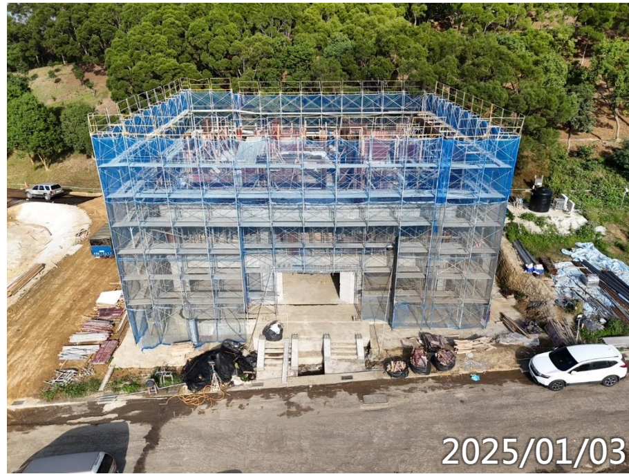
男常住3F柱牆施作
