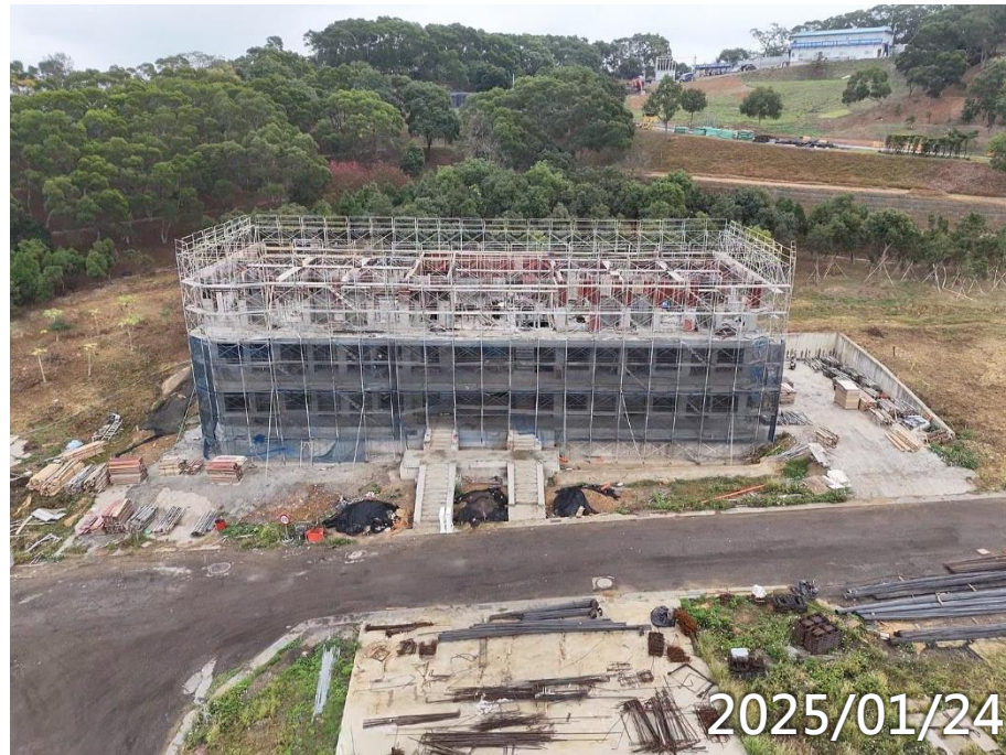
男義工3F柱牆RF梁施作
