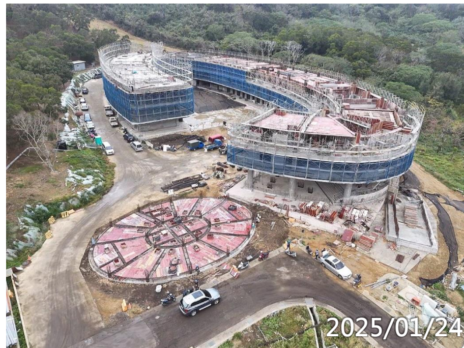
女寮3F柱牆4F梁版澆置(南區) 3F柱牆4F梁版施作(北區)
