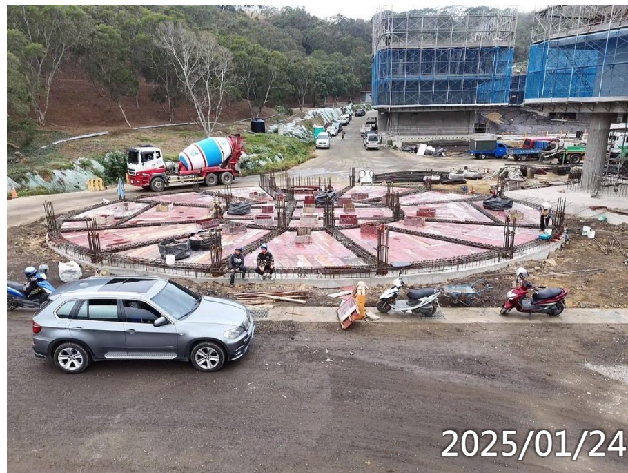
女常住基礎層施作
