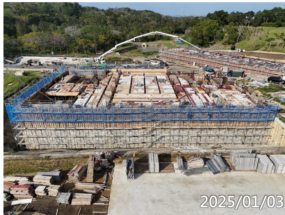
玄文B1F柱牆1F梁版施作
