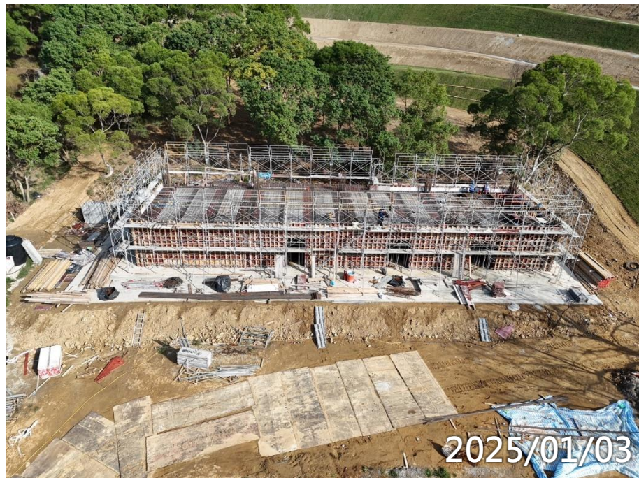
司機休息室1F柱牆2F梁版施作
