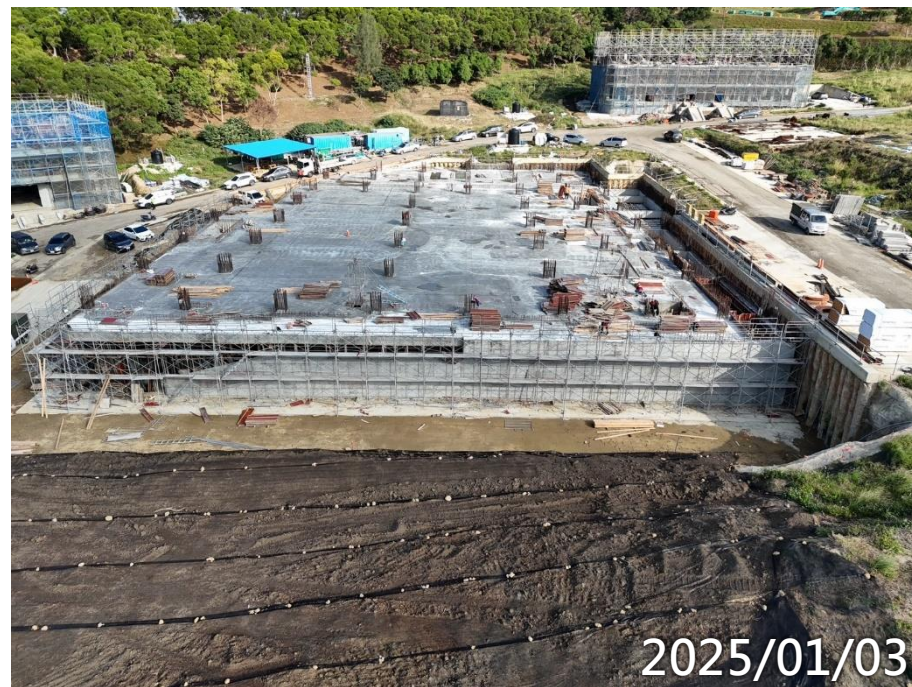
齋堂1F柱牆2F梁版澆置
