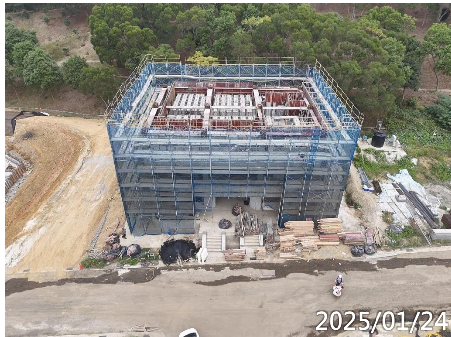
男常住3F柱牆RF梁施作
