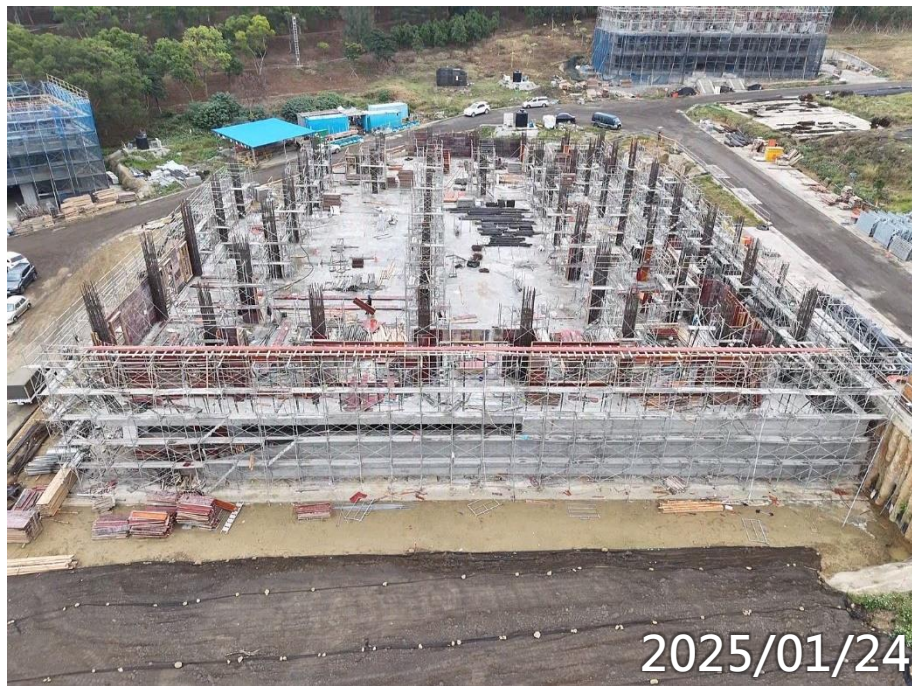
齋堂2F柱牆施作
