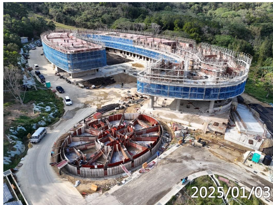
女寮3F柱牆4F梁版施作
