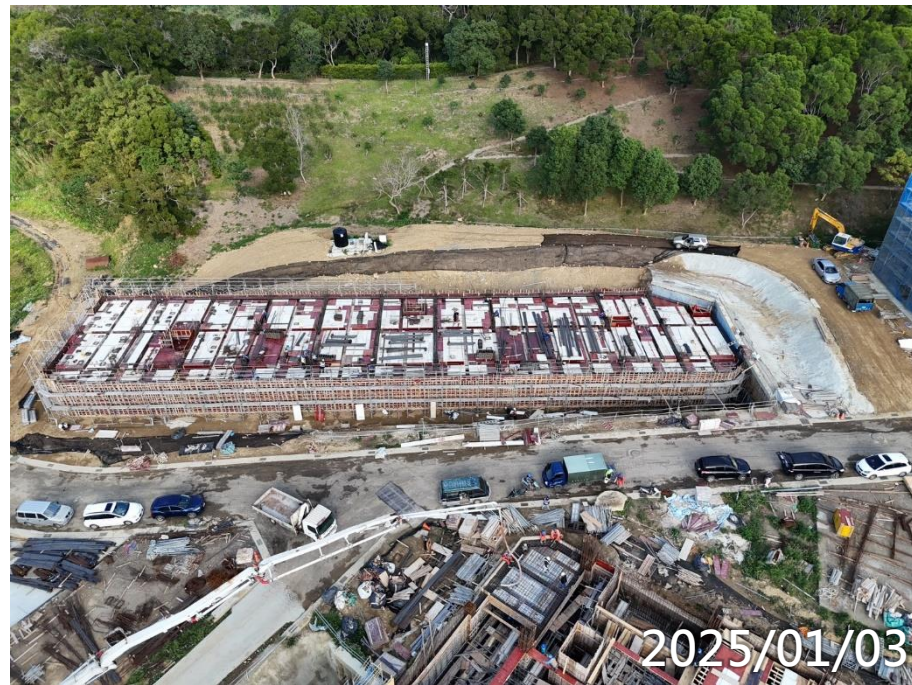
男寮B1F柱牆1F梁版施作
