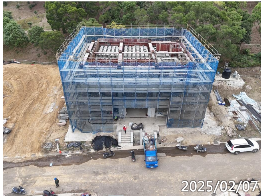
男常住3F柱牆RF梁施作
