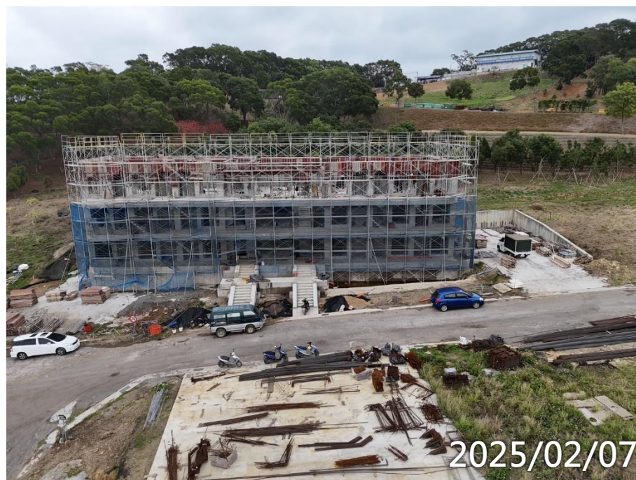
男義工3F柱牆RF梁施作
