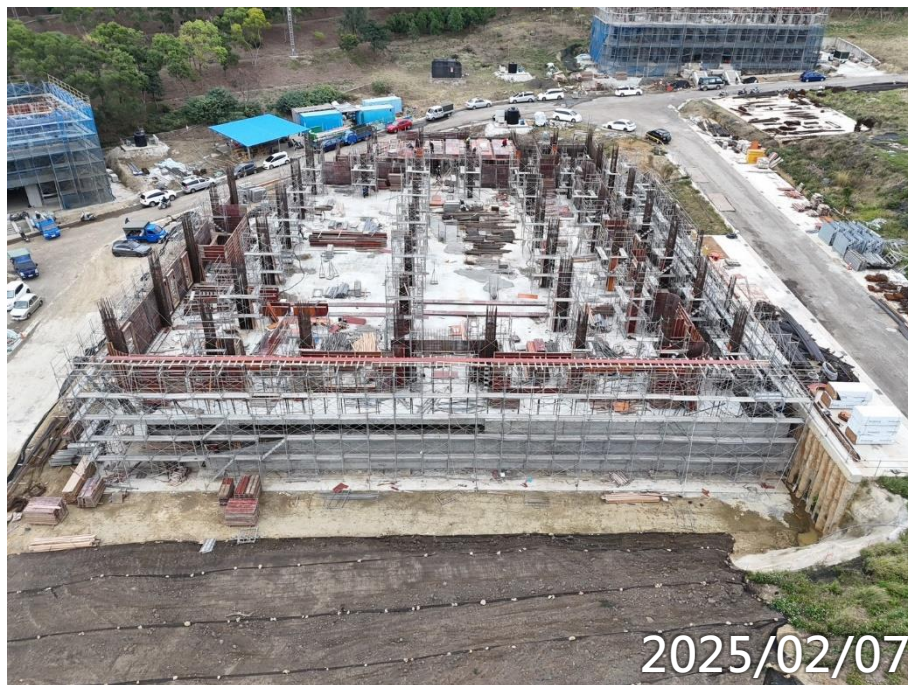
齋堂2F柱牆、3F梁版施作
