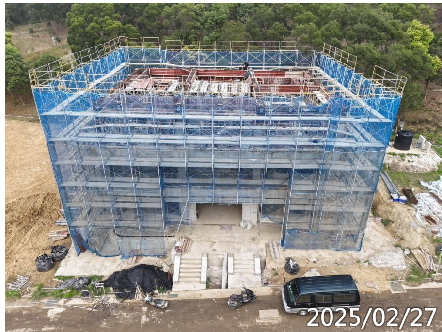
RF梁鋼筋模板水電施作
