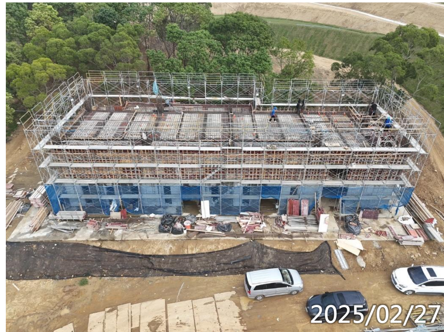
3F梁版鋼筋模板水電施作
