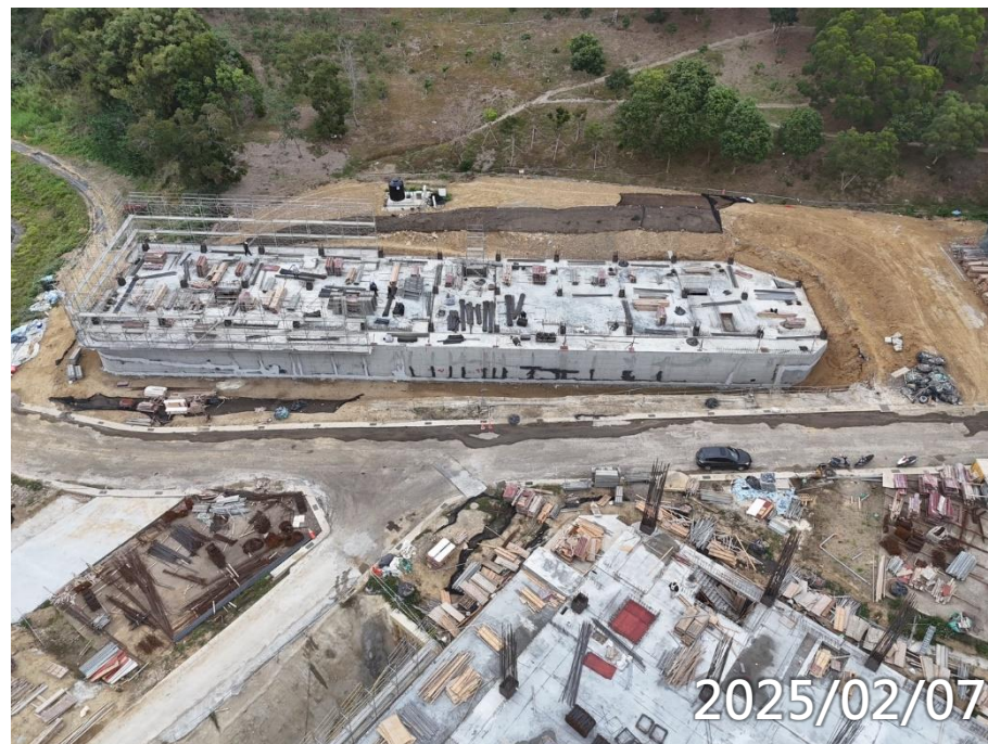
男寮B1F外牆層縫防水施作 外架拆除 鋼軌樁拔除
