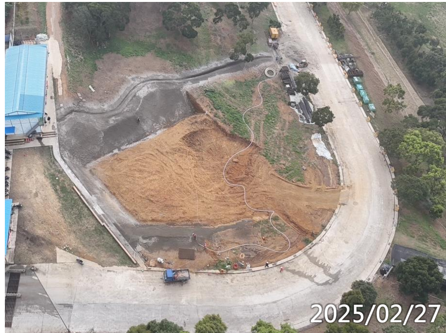
土方開挖、噴漿護坡
