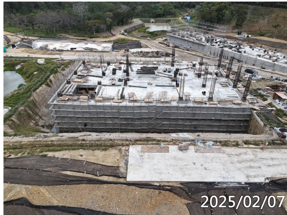
玄文1F柱續接 外牆層縫防水施作
