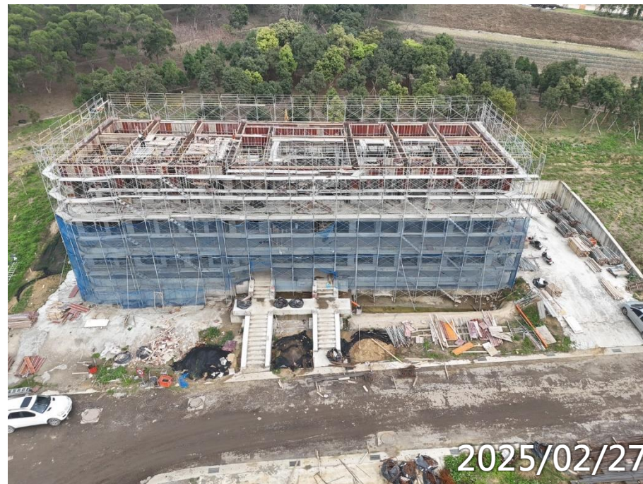
RF梁鋼筋模板水電施作
