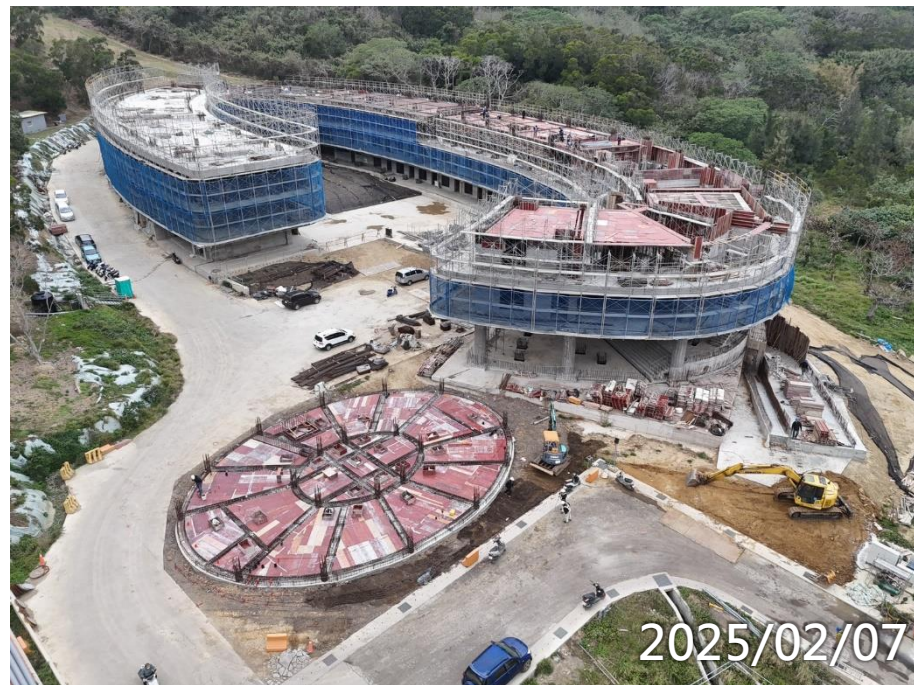
女寮3F柱牆4F梁版施作(北區)
